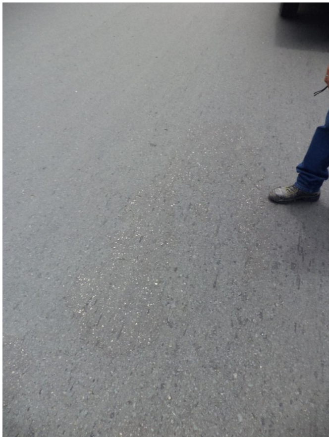
BACHES REPARADOS (SEVERIDAD BAJA)
