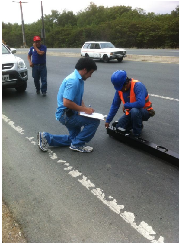
Figura 5.9 Toma de lecturas en el dial de deformación
