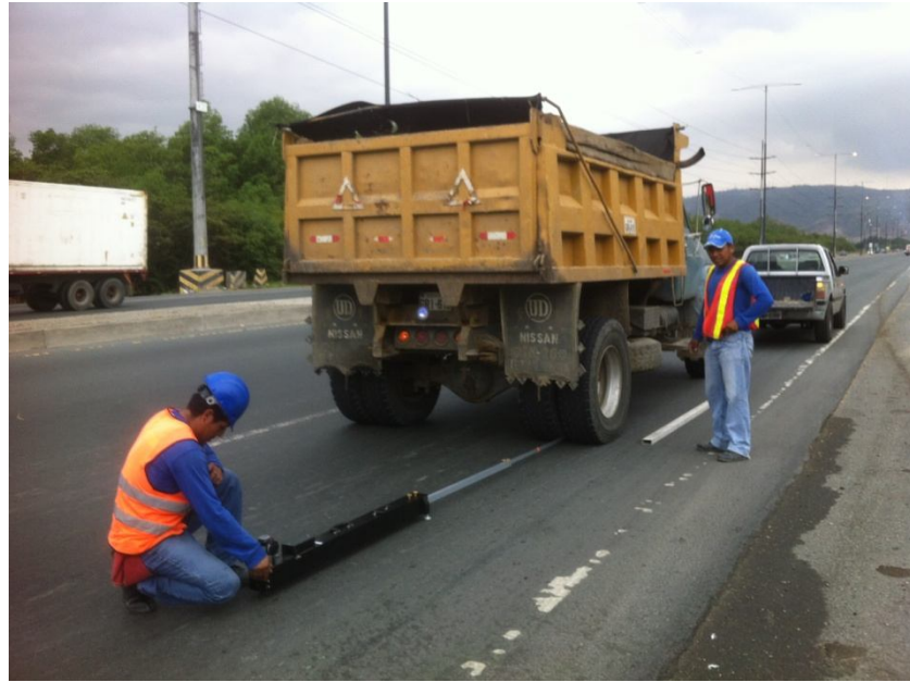
Figura 5.6 Viga Benkelman utilizada en ensayos
