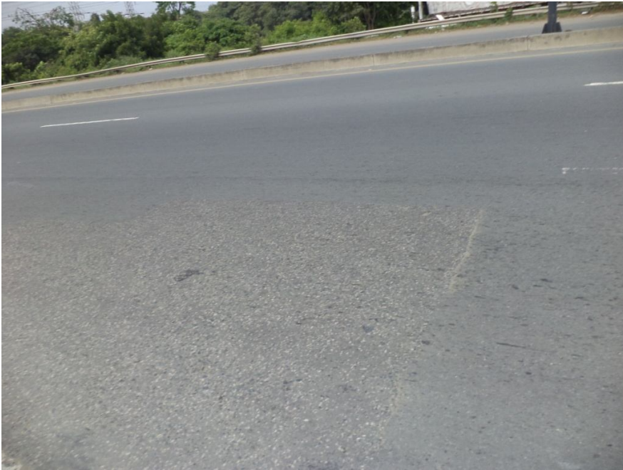
BACHES REPARADOS (SEVERIDAD BAJA)
