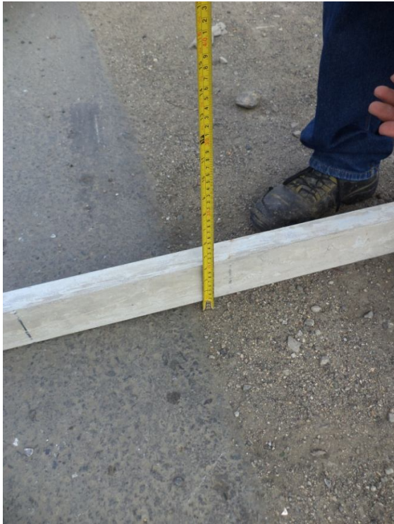
DESNIVEL CALZADA-HOMBRO (SEVERIDAD BAJA)
