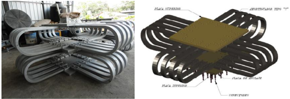
Figura 45 Sistema de Rolado en U Utilizado en el Punte Napo, Ecuador (Sísmica Ingenieros Consultores, 2013)
