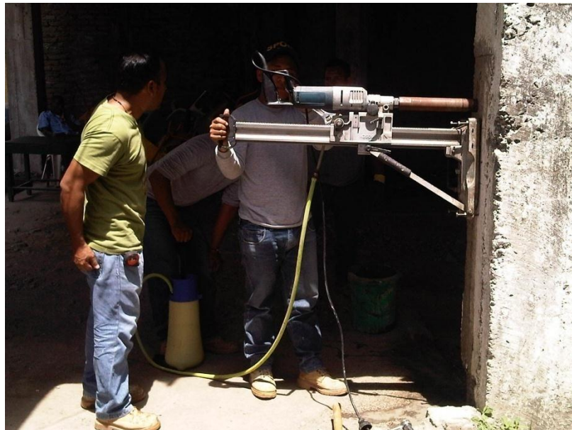
Figura 14 Extracción de núcleos de Hormigón
