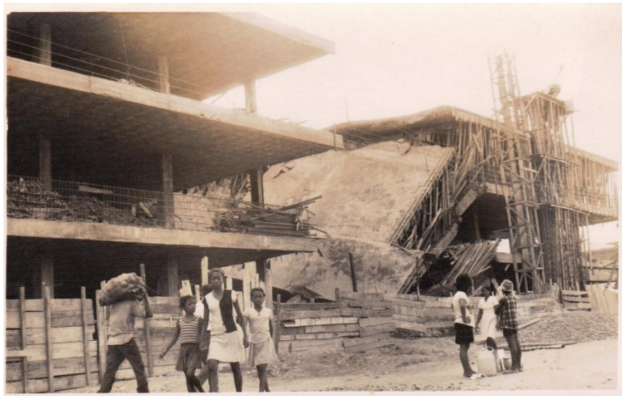
Figura 1 Fotografía tomada el día después al sismo
