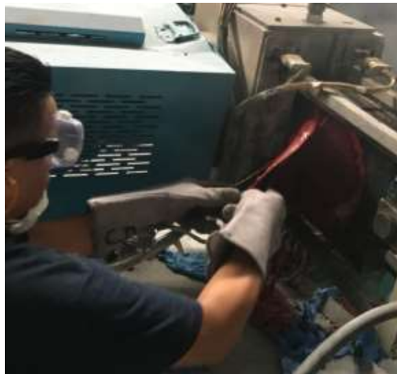
Figura 31. Operador extrayendo la malla contaminada.
