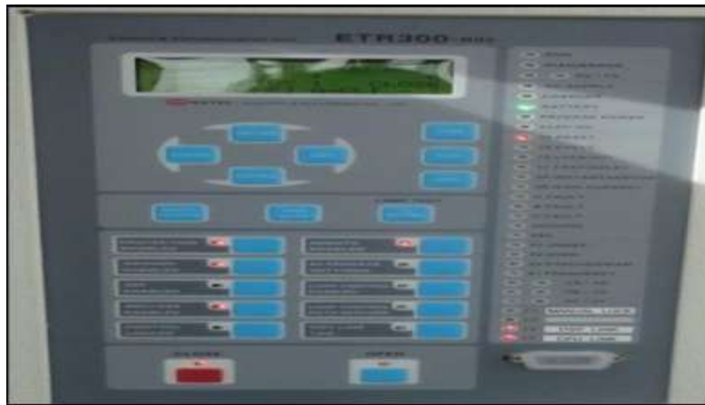
Figura 2. 4 Relé ETR 300 que controlan a reconectadores Fuente: ENTEC Electric y Electronic 2009).
