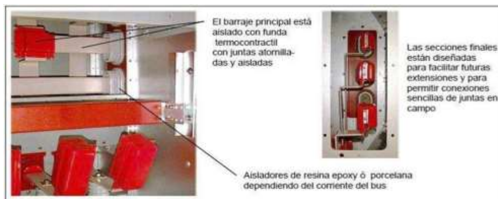
Figura 2. 18 Barra colectora de sección rectangular de celdas ABB
