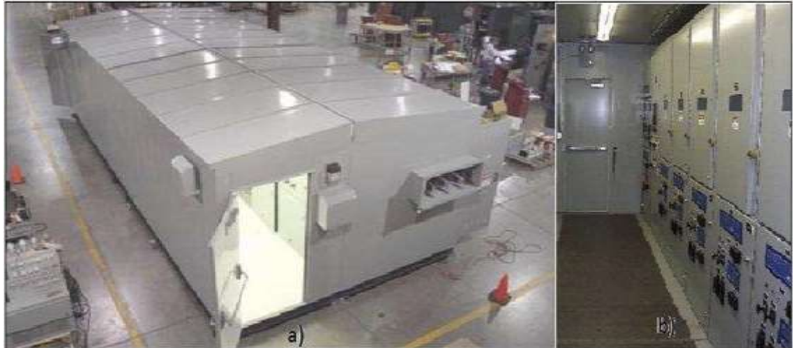
Figura 2. 10 a) Celda metal-clad de tipo exterior con pasillo. b) Celda metal-clad de tipo exterior con pasillo.
