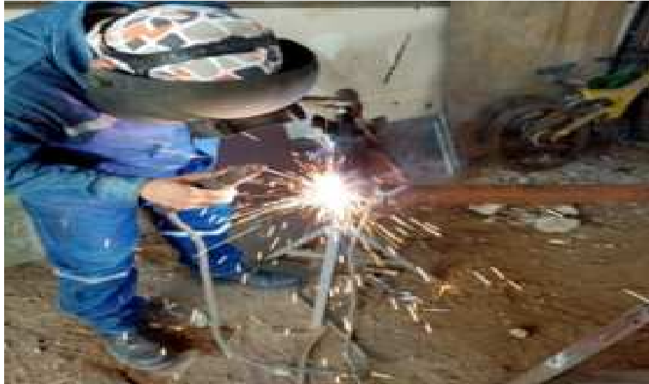
Figura 25. Construcción de líneas de 1" ½ para la conducción de los gases
