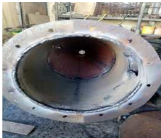
Figura 24. Soldadura y armado del ciclón
