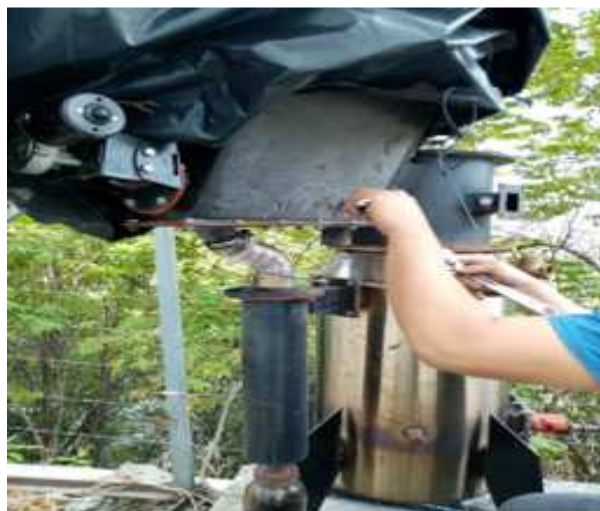
Figura 20. Desarmado de partes del gasificador
