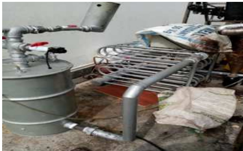
Figura 29. Partes nuevas del equipo ubicadas e instaladas
