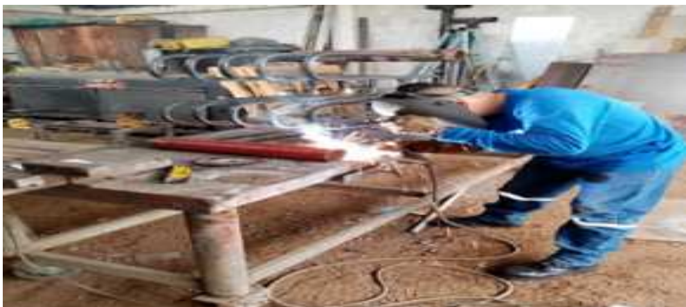
Figura 28. Fabricacion de serpentín tipo u para retencion de condensación
