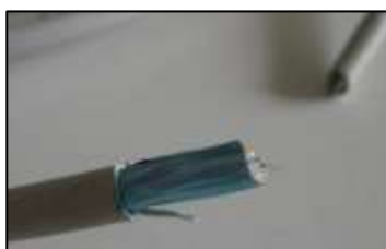
Figura 4. 9: Corte del cable de red. Fuente: Autor
