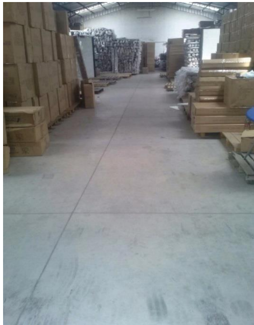
Ilustración 15. Pasillos de bodega Fuente: (DEBSA, 2019)
