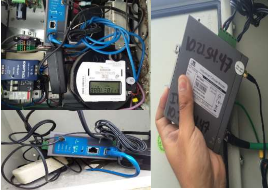
Figura 3.13 Colector AMI con Modem Inhand
