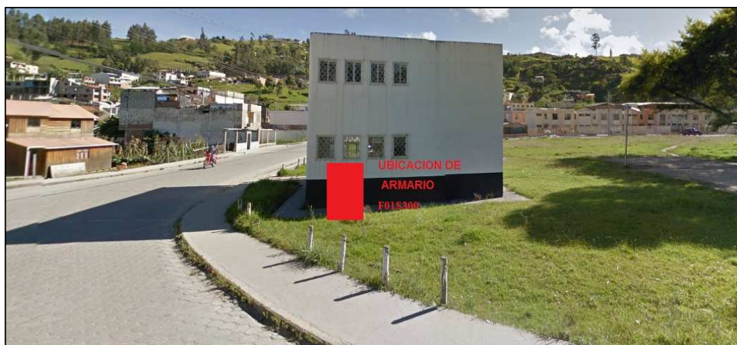
Figura 3.8 Ubicación de OLT exterior F01S300
