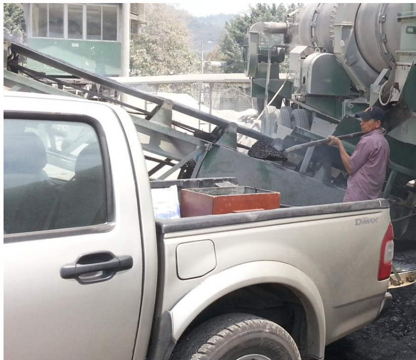
Gráfico 7-1: Obtención de mezcla asfáltica en caliente directamente de la planta.
