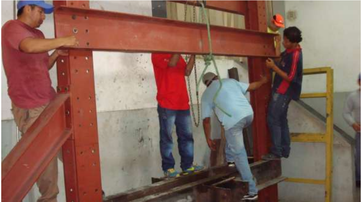
Foto 29. Pórtico donde se van a realizar los ensayos de corte y compresión diagonal
