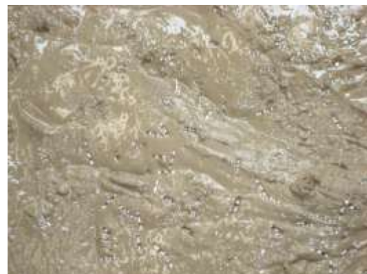
Foto 7. Mezcla 1 saco de cemento, arena, agua y fibra de acero
