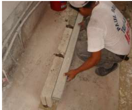
Foto 9. Proceso de construcción de paredes
