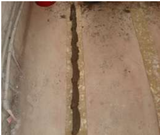
Foto 8. Se utilizan tiras de cartón como de base para las paredes
