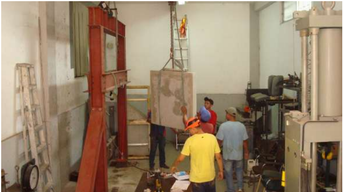
Foto 28. Traslado de la pared con la ayuda del tecele y del personal
