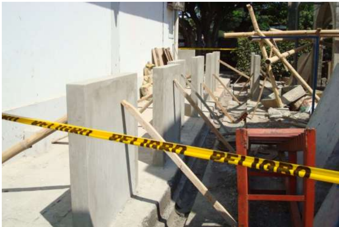
Foto 11. Vista de las paredes concluidas
