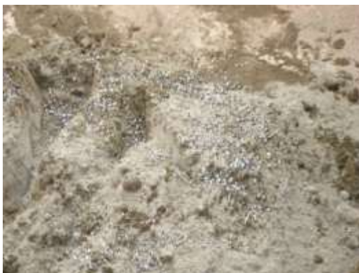
Foto 6. Mezcla de 1 saco de cemento, arena y fibra de acero
