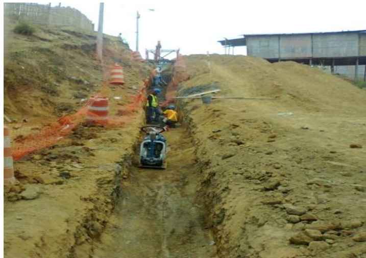
Foto #5 Instalación de tubería
