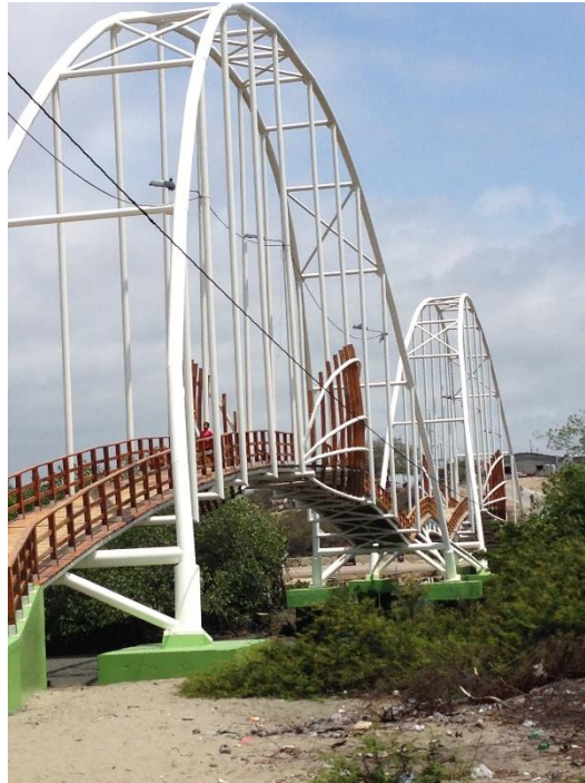
Puente peatonal de la comunidad Bellavista en la Isla Puná
