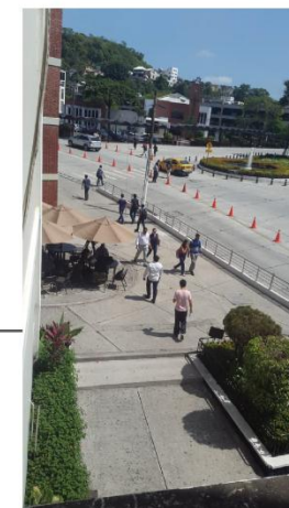
Fig. 36: Barandas peatonales como seguridad Autor: García C. (2019)
