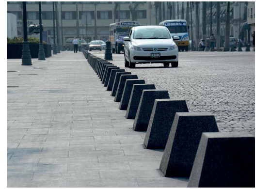
- BOLARDOS DE HORMIGÓN.
