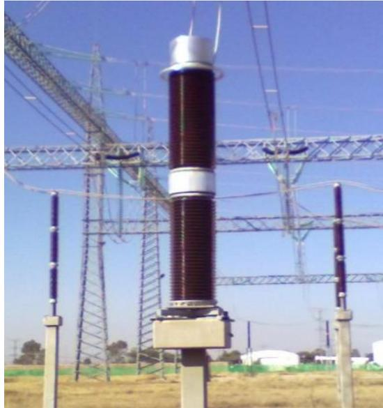
Figura 2. 29 Transformador de potencial en SE 69 kV
