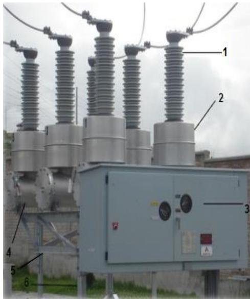
Figura 2. 15 Interruptor de potencia en SF6 tipo DT1-72,5
