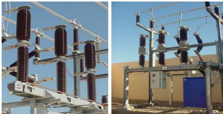
Figura 2. 12 Interruptores de alta tensión
