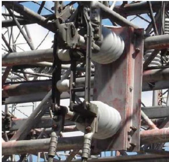
Figura 2. 20 cuchillas seccionadoras
