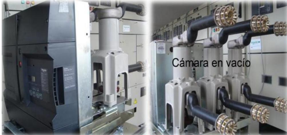
Figura 2. 16 Interruptor de potencia en vacío para 24 kV
