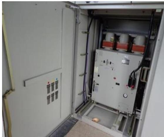
Figura 2. 17 Celda de Media Tensión de una SE
