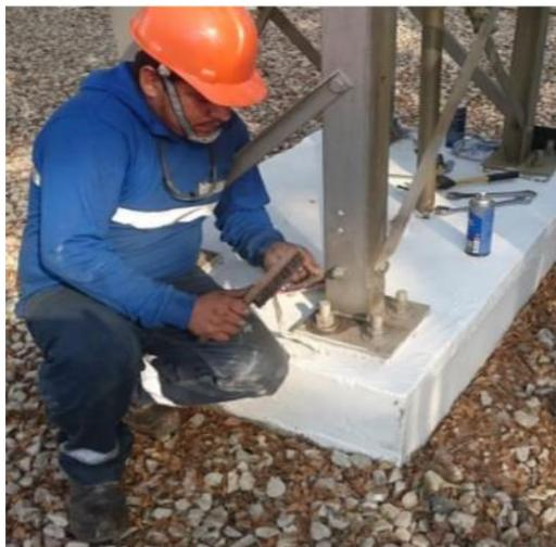
Figura 4. 6 Puntos de conexión de puesta a tierra
