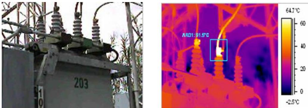
Figura 3. 7 Termografía infrarroja de un reconector
