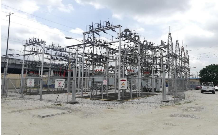
*Figura 2.11. Subestación eléctrica de intemperie*
