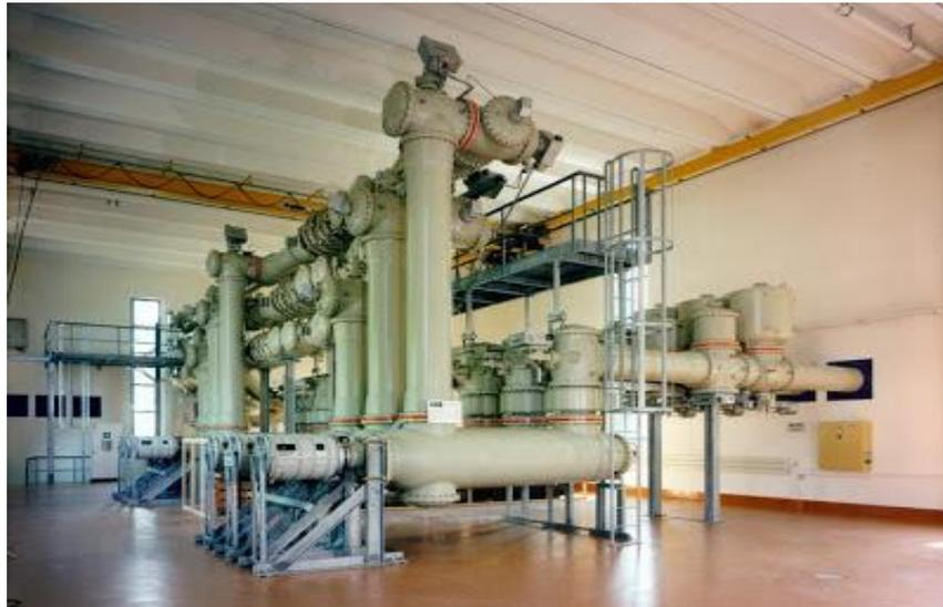
*Figura 2. 13. Subestación eléctrica tipo blindada*
