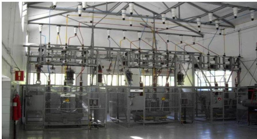
*Figura 2.12. Subestación tipo interior*
