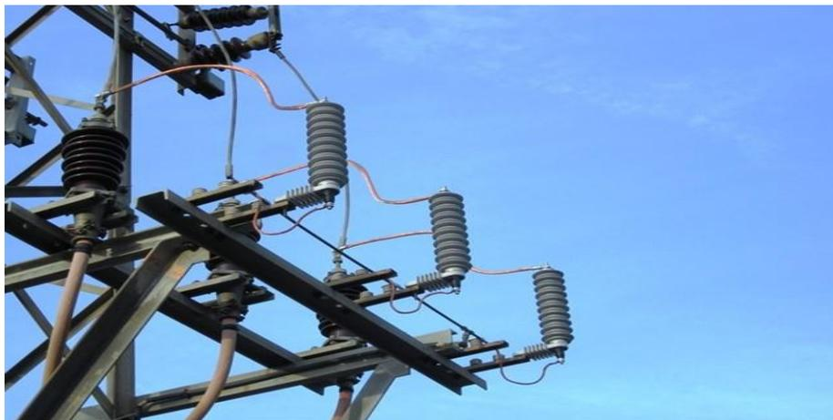
*Figura 2. 10. Pararrayo de subestación eléctrica*
