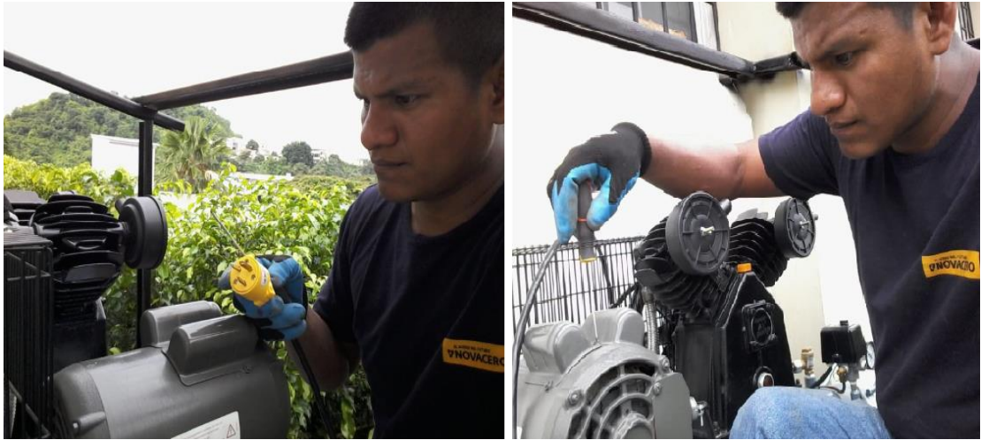
Figura 4. 12 Conexión eléctrica a 220 monofásico
