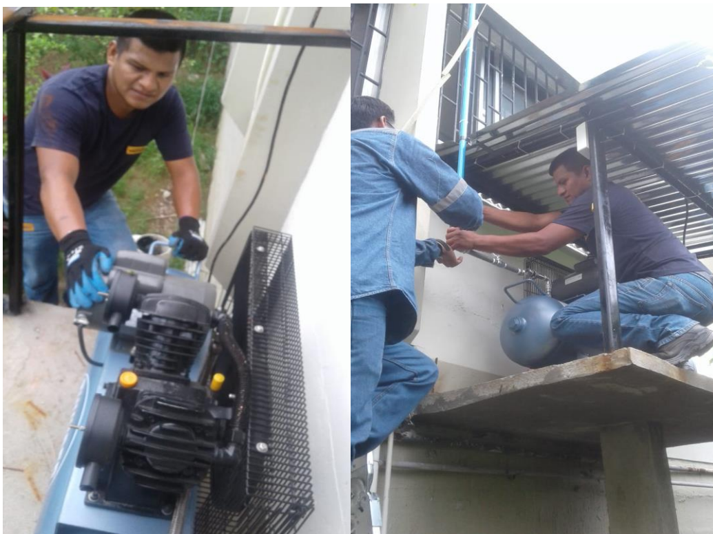
Figura 4. 9 Montaje del compresor en loseta
