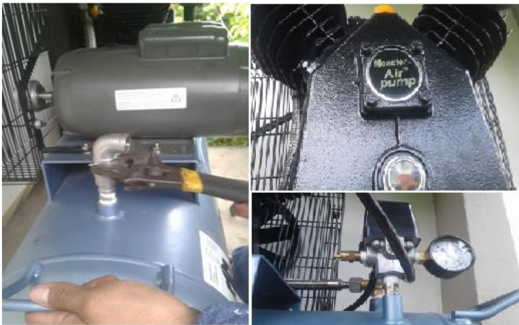
Figura 4. 11 Instalación de tubería principal y accesorios
