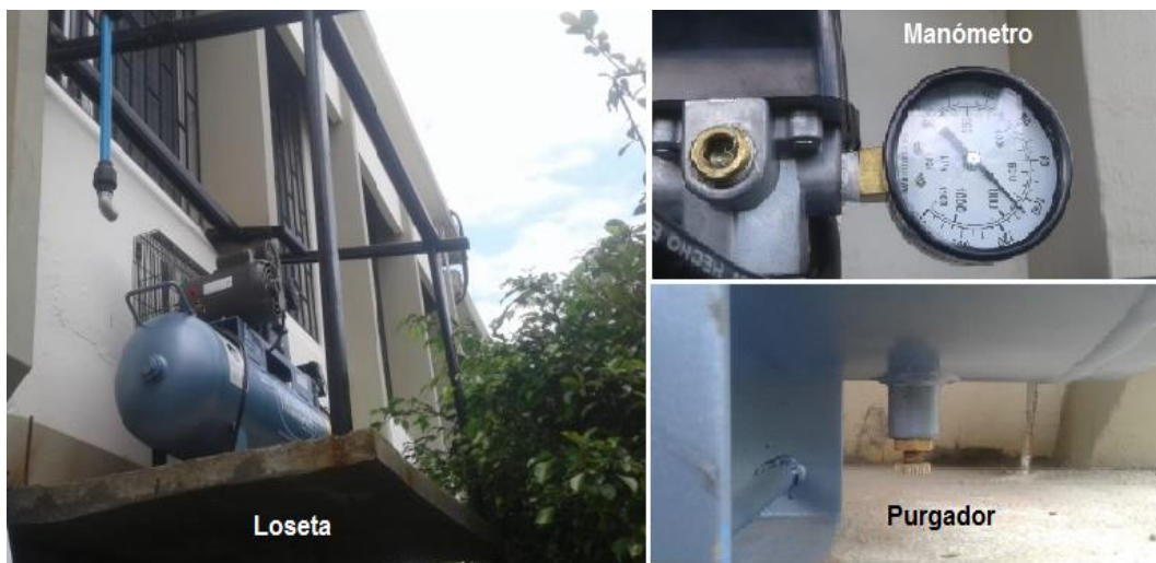
Figura 4. 10 Ajustes de manómetro y purga
