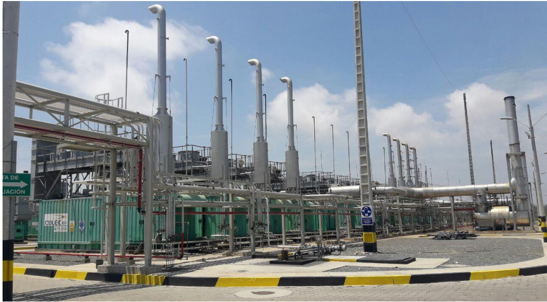
Figura 2.2: Conjunto turbina-generator de la central térmica Gonzalo Zevallos G. Tomado de Celec EP.
