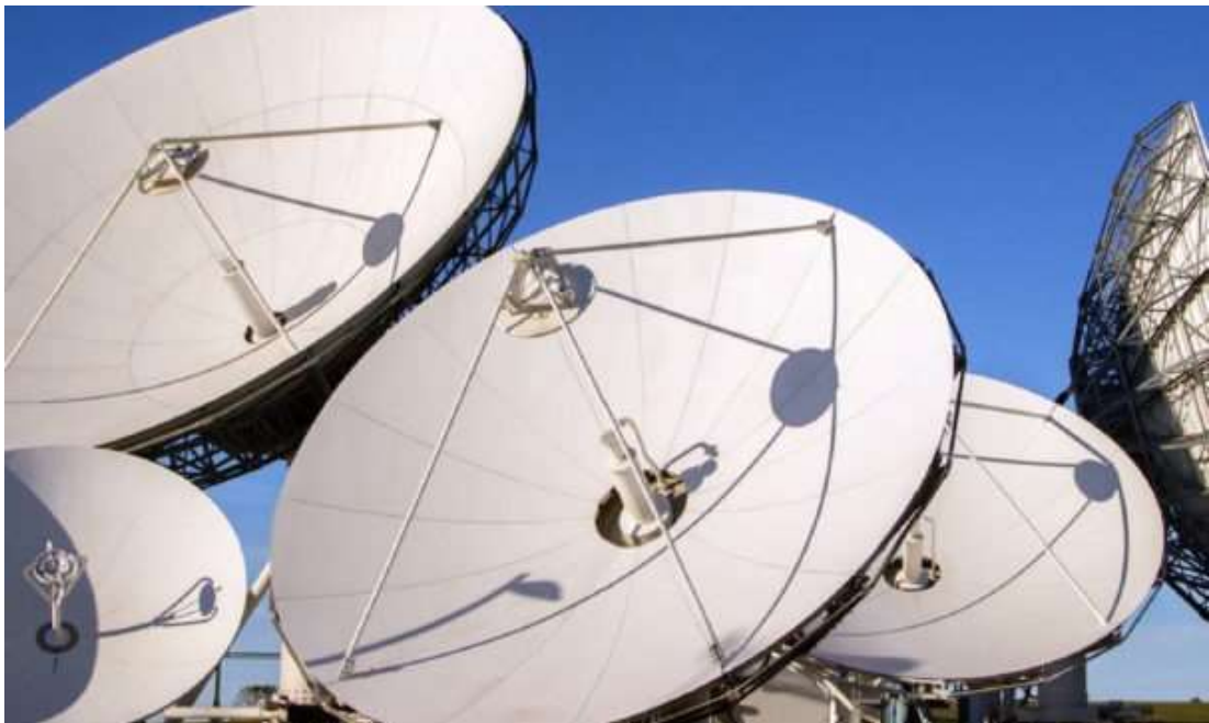
Figura 2. 2 Antenas VSAT fijas. Fuente: (SATMARIN, 2011)
