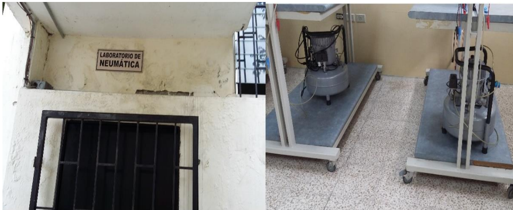
Figura 4. 1 Laboratorio de Neumática y compresores de aire comprimido
