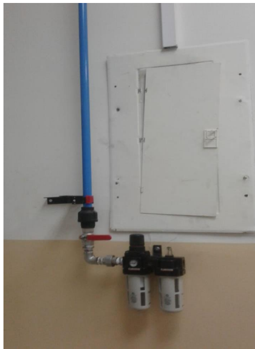
Figura 4. 15 Instalación de la Válvula de cierre y unidad de mantenimiento
