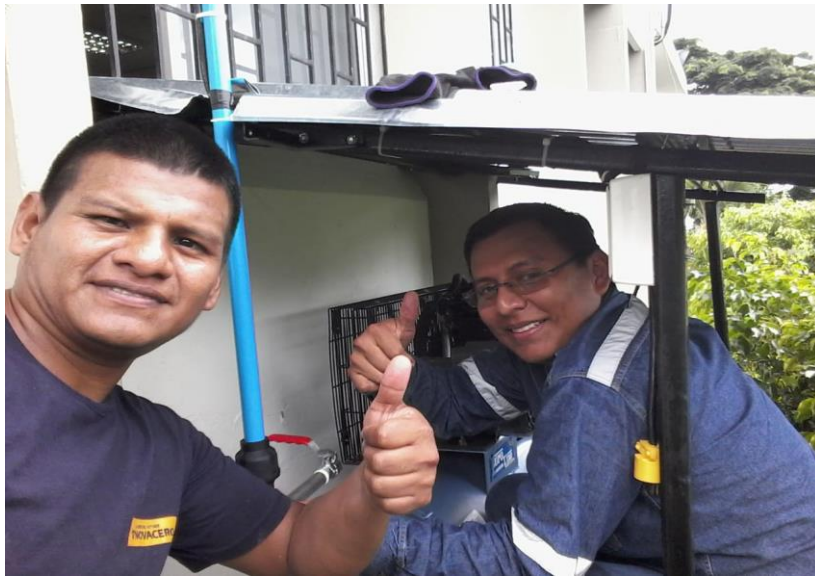
Figura 4. 14 Instalación del compresor de pistón 3 hp
