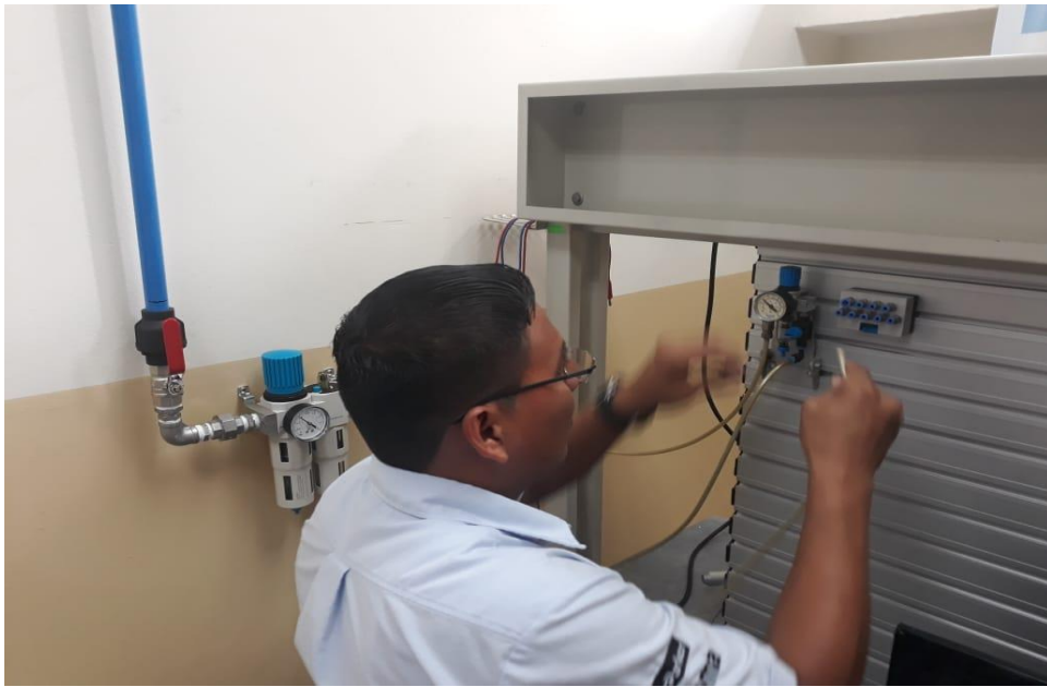
Figura 4. 18 Conexión de mangueras en tablero FESTO
