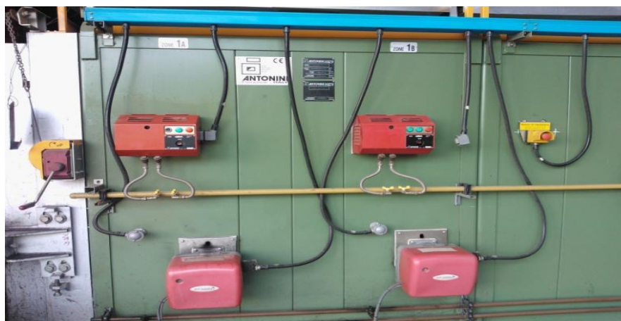
Figuras 2.2.e2 Quemadores a gas Antonini y quemadores a diésel Euro 9 Fuente: Autor
