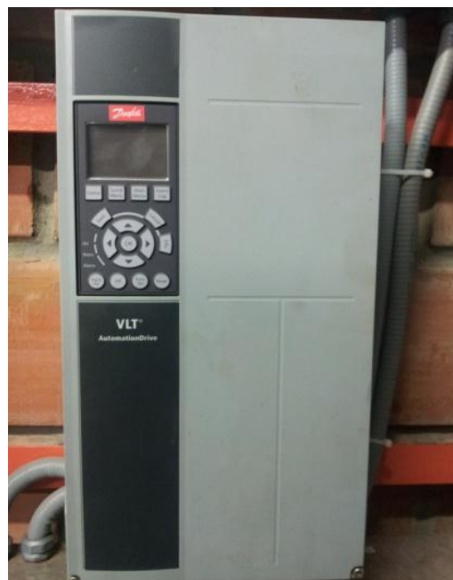
Figuras 3.2 Variador Danfoss FC301 Fuente: Autor
