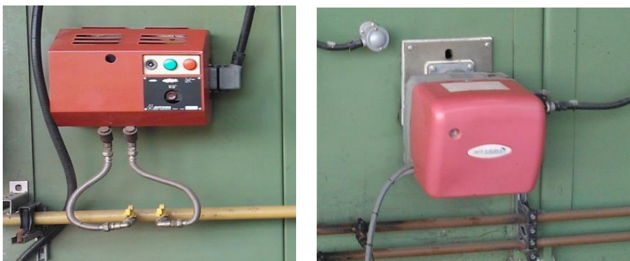
Figuras 2.2.e1 Quemador de Gas y Quemador de Diésel
