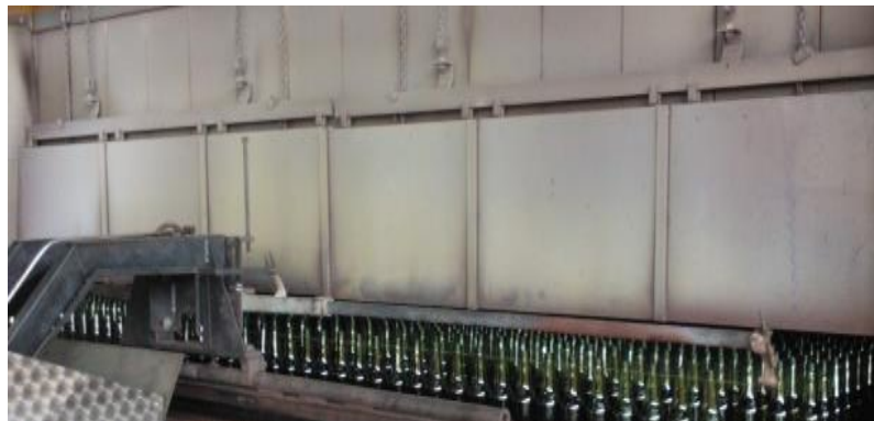
Figuras 2.2.a Puerta de entrada del Acondicionador Fuente: Autor
