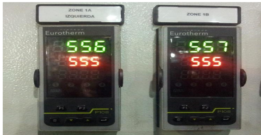
Figuras 2.2. d Controlador Digital de temperatura Eurotherm Fuente: Autor
