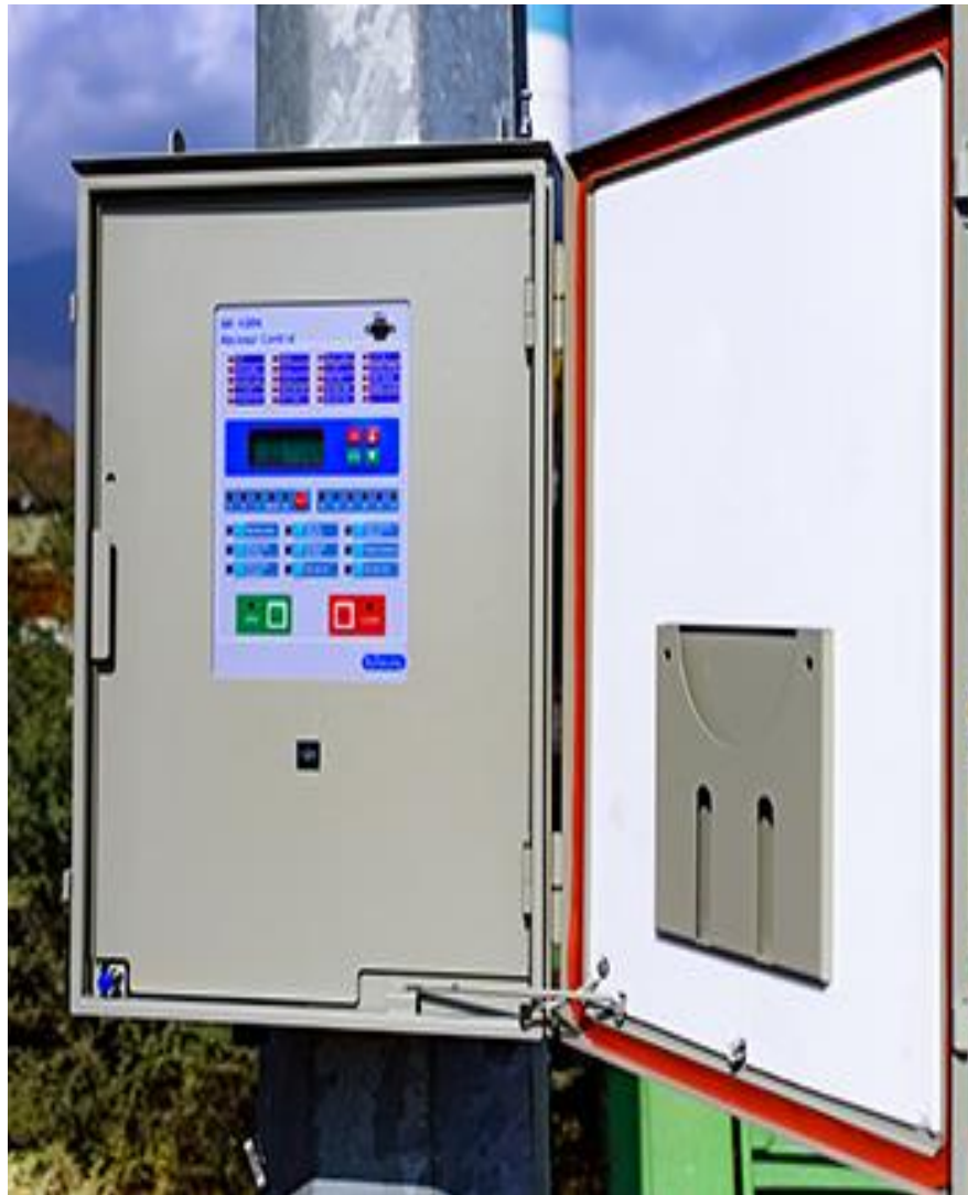
Figura 6.3: Reconectador automático montado en poste. Fuente: (Co, BR-10RN Recloser Control, 2014)
