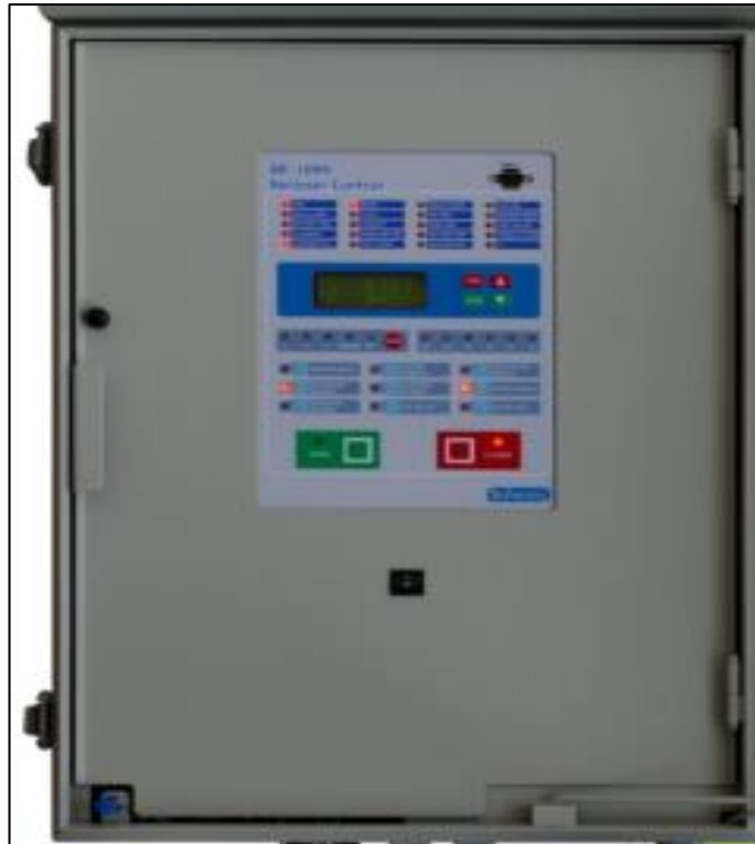
Figura 5.1: Control del Reconectador Automático Fuente: (Nieto, 2018)
