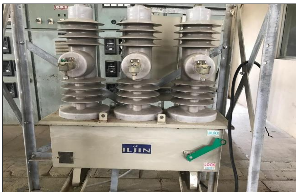
Figura 4.1: Reconectador Automático Elaborado por: Autor
