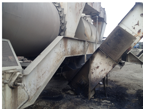
FOTO 8. DETALLE DE PLANTA DE ASFALTO
