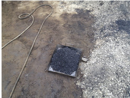
FOTO9. TOMA DE MUESTRA DE MEZCLA ASFÁLTICA
