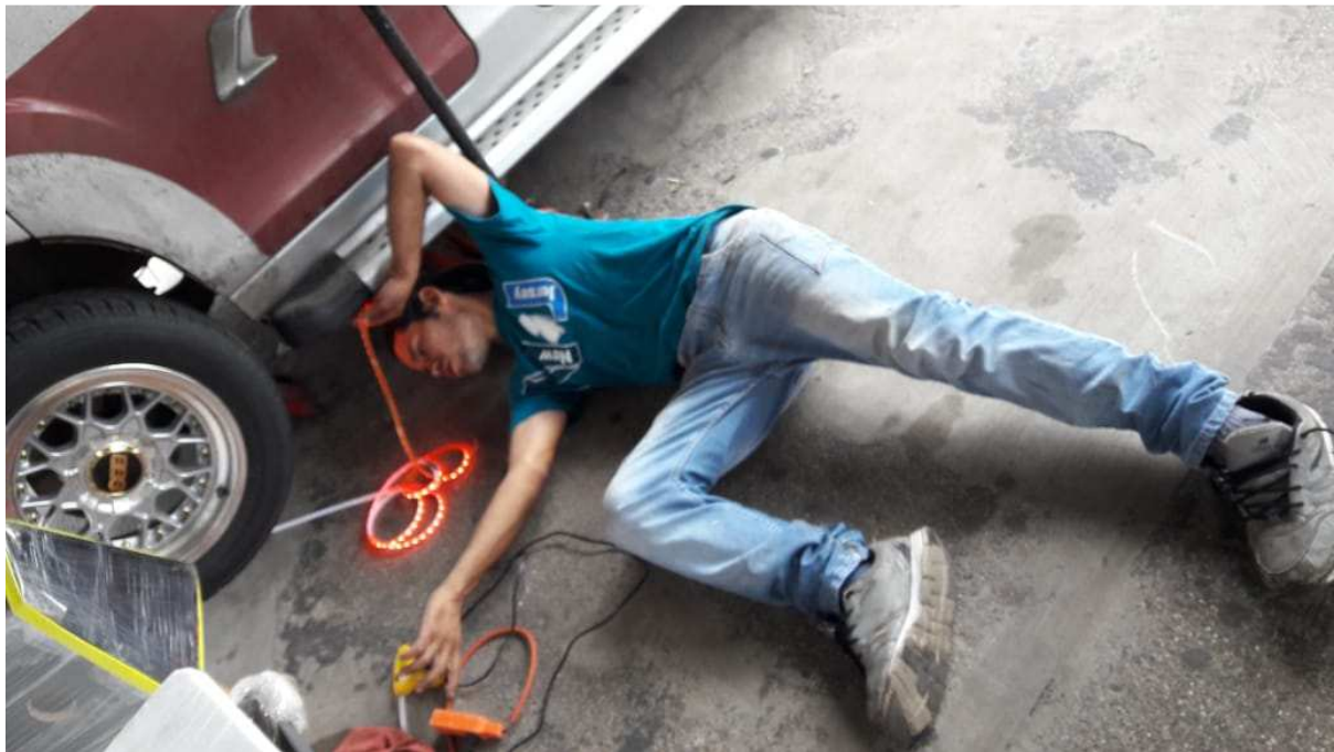
Figura 52. Instalación de producto
