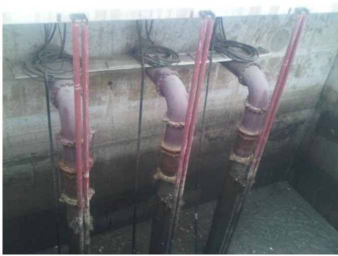
Foto 8.- Bombas Sumergibles
