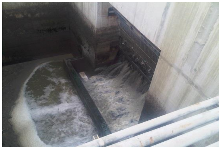
Foto 6.- Disipador de Energía
