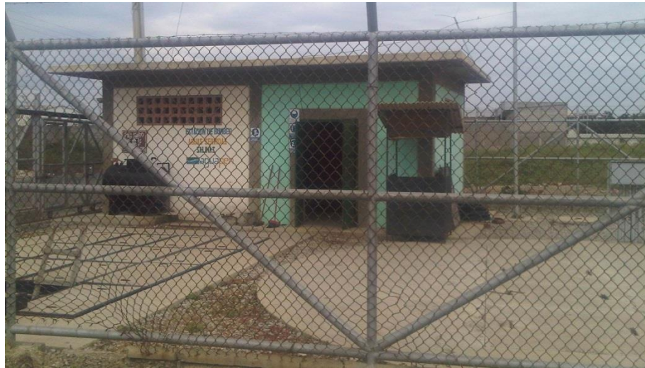
Foto 2.- Estación de Bombeo de Salinas (EB#1)
