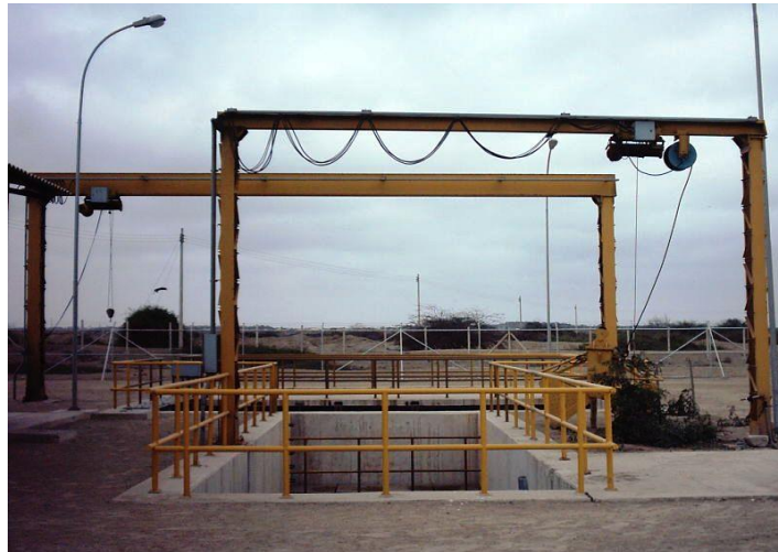
Foto 3.- Puente de Grúa
