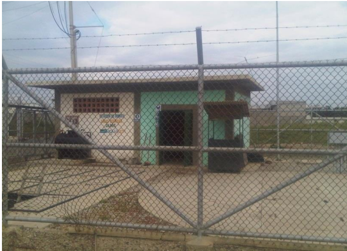
Foto 2.- Estación de Bombeo de Salinas (EB#1)
