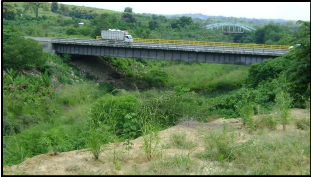
Figura 4-1 Puente de Cerecita ubicado sobre el río "Grande".
