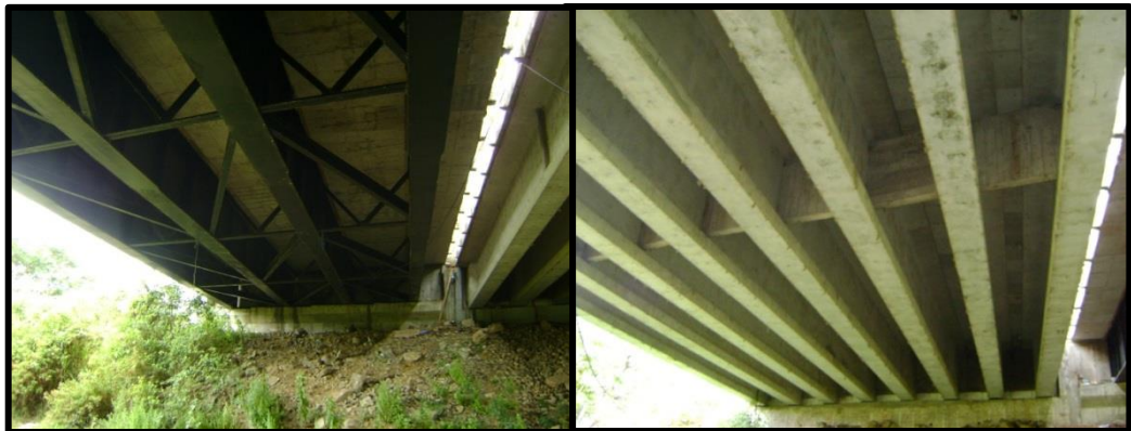
Figura 4-4 Puentes sobre el río “Camarona”.
