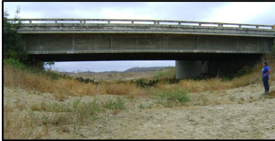
Figura 4-10 Estructura sobre el río “Salado”.
