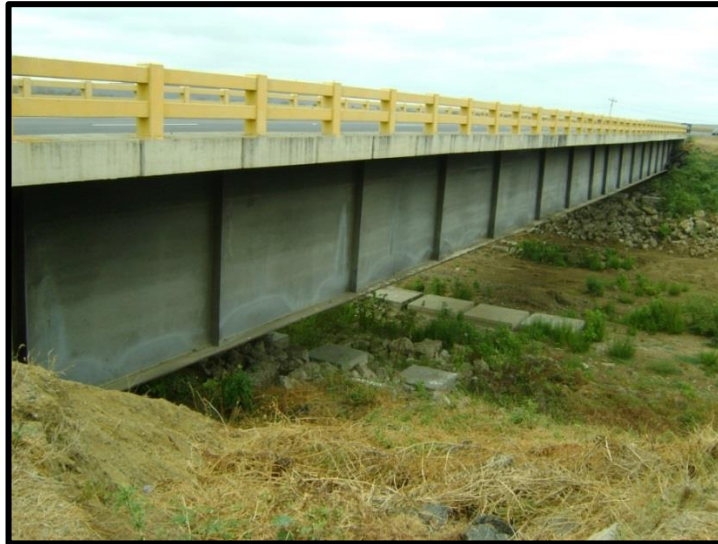
Figura 4-7 Puente con estructura metálica sobre el río “Zapotal”.
