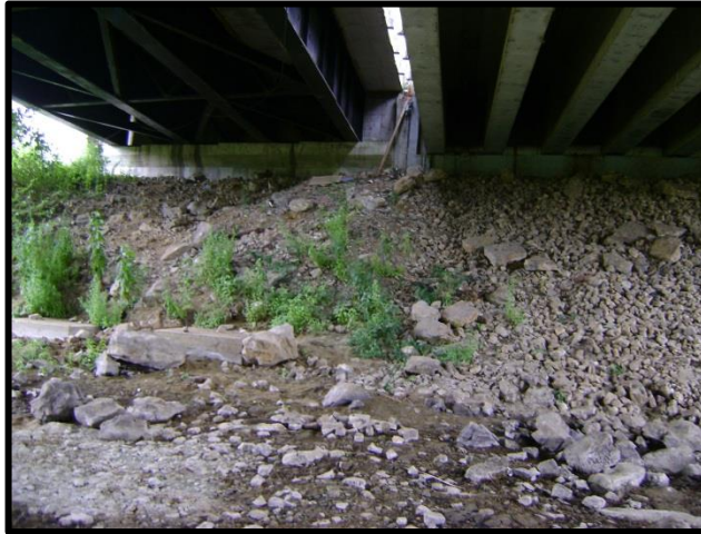
Figura 4-6 Diferencia de protección de estribos entre los puentes del río “Camarona”.
