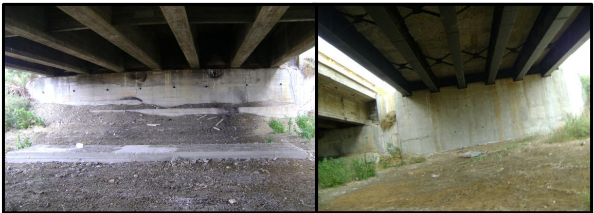
Figura 4-11 Estribos y vigas de la estructura sobre el río “Salado”.
