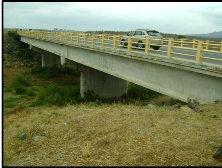
Figura 4-8 Puente con estructura de hormigón sobre el río “Zapotal”.
