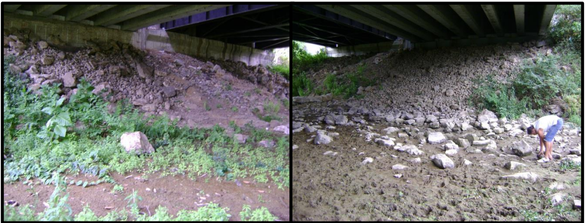
Figura 4-5 Enrocado en los estribos del puente aguas abajo del río “Camarona”.
