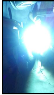
Figura 3. 5. Soldadura de tanques Elaborado por: Autor
