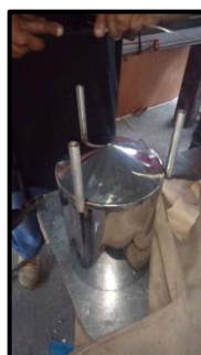
Figura 3. 9. Soldadura de soporte para tanques Elaborado por: Autor
