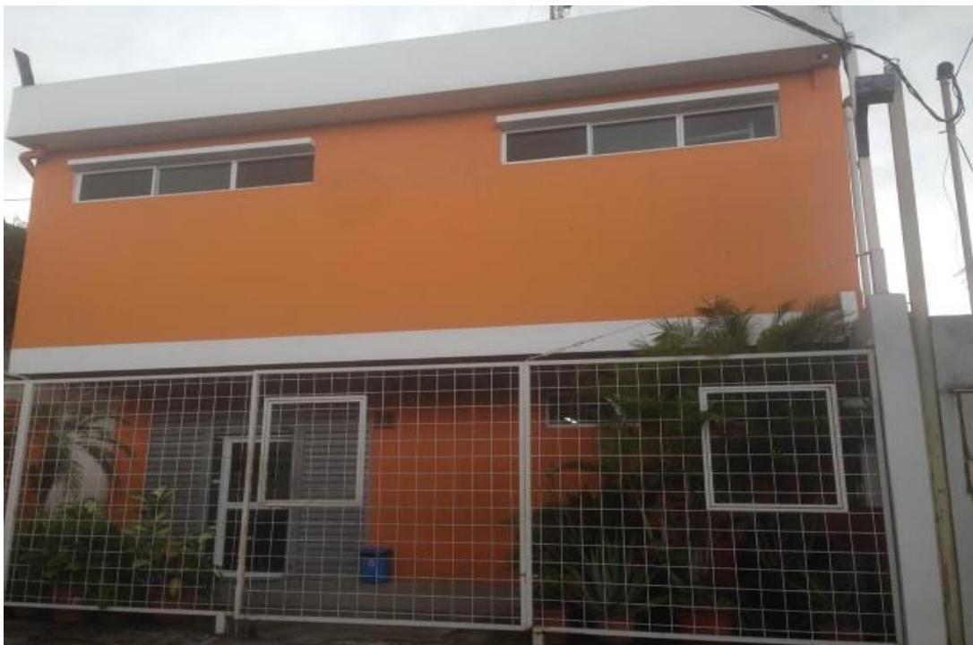
Centro de rehabilitación Jorge Andrade.
