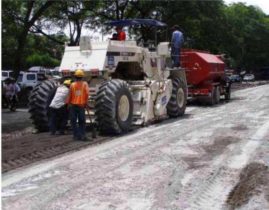
**Figura 2.8.- Aplicación de la base estabilizada con cemento en obra**
