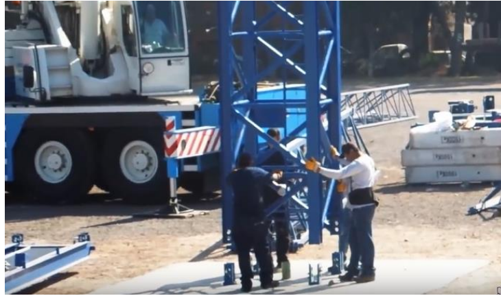
Ilustración 145.- Instalación de tramo inicial con la cimentación Fuente: Internet
