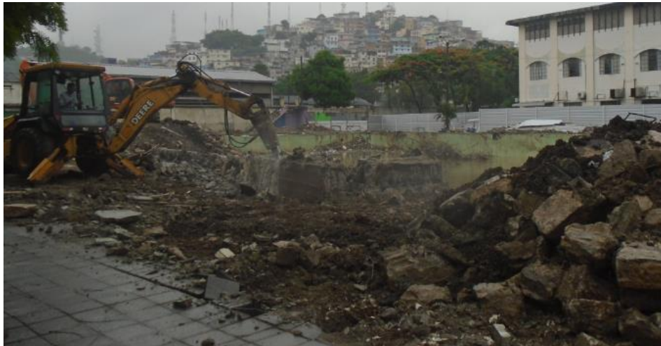
Ilustración 48.- Retroexcavadora con martillo hidráulico Fuente: Ing. Rafael Camacho
