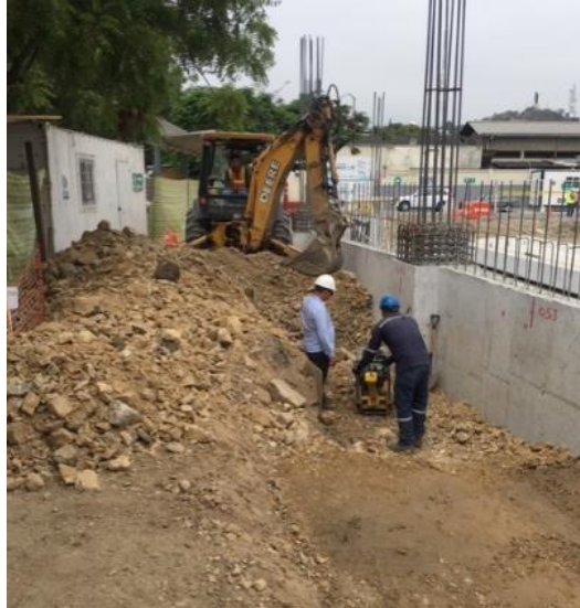
Ilustración 108.- Relleno de muro perimetral
