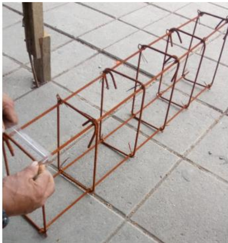
Ilustración 39.- Acero para bases de cerramiento Fuente: Autor
