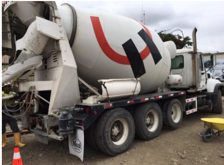
Ilustración 100.- Mixer para fundición de muros perimetrales Fuente: Autor
