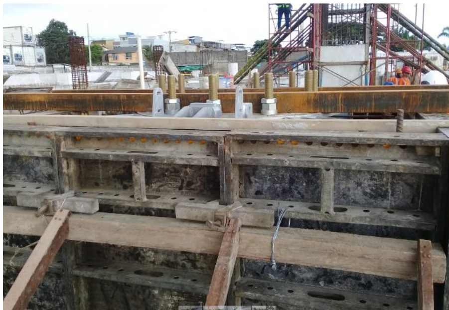
Ilustración 123.- Ubicación final de pernos de anclaje Fuente: Autor
