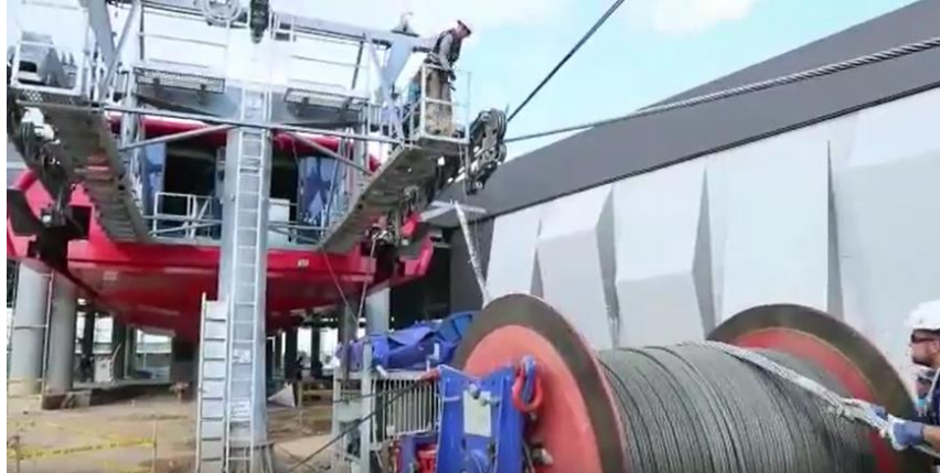
Ilustración 208.- Poleas mecánicas para instalación de cable de acero final Fuente: Internet
