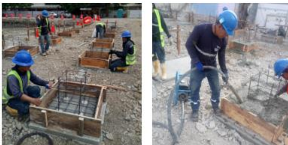
Ilustración 55.- Fundición de bases
