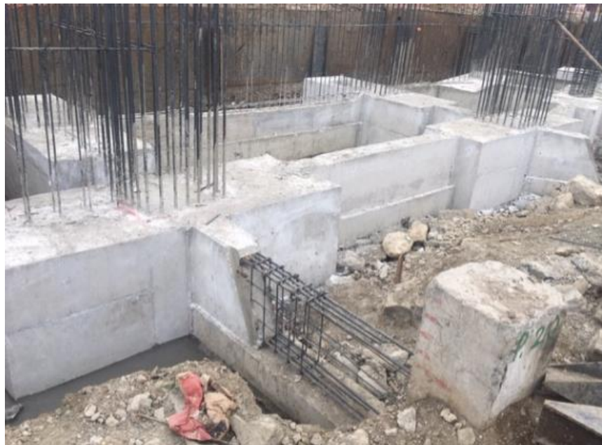
Ilustración 97.- Traslape de vigas de cimentación Fuente: Autor
