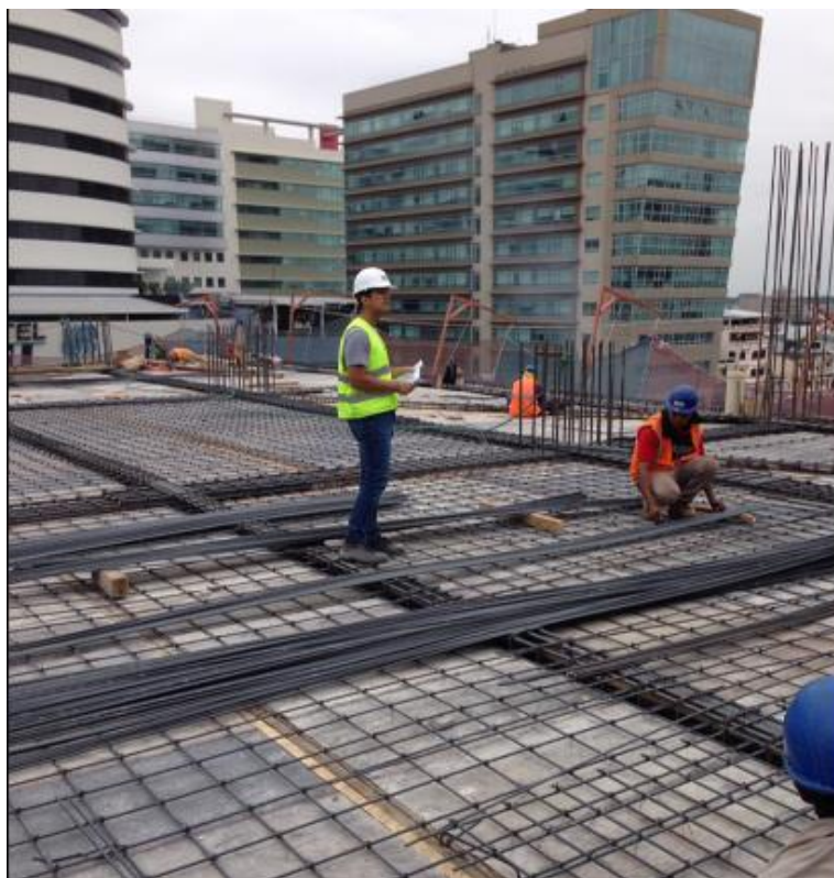
Ilustración 171.- Refuerzo de losa con vigas presforzadas Fuente: Jorge Romero
