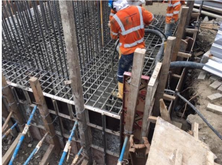
Ilustración 118.- Fundición de cabezal de pila P.16-17
