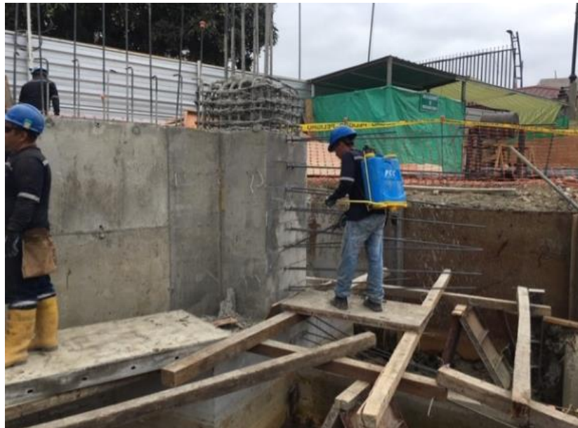
Ilustración 107.- Curado de muro perimetral Fuente: Autor
