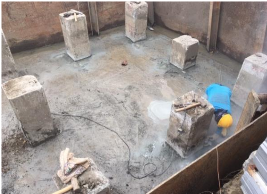
Ilustración 91.- Marcación de niveles en pilotes a descabezar Fuente: Autor
