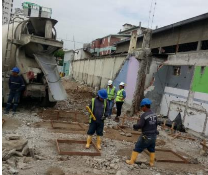
Ilustración 54.- Fundición de replantillo
