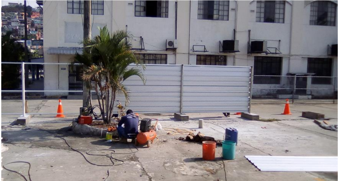
Ilustración 40.- Instalación de cerramiento perimetral
