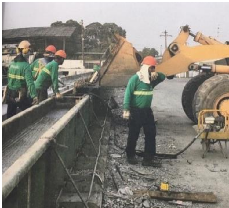
Ilustración 66.- Fundición de pilotes
