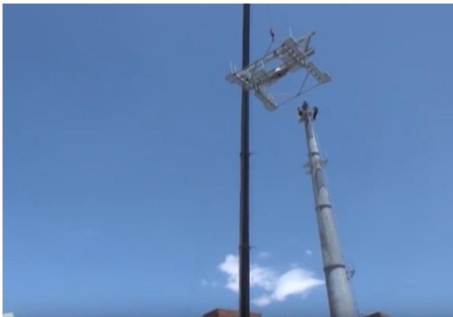
Ilustración 177.- Colocación de balancines en parte superior de pilonas Fuente: Internet
