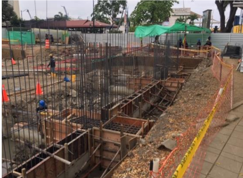
Ilustración 98.- Encofrado para fundición de 1era etapa Fuente: Autor
