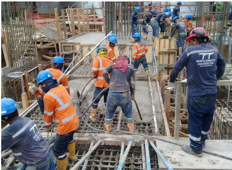
Ilustración 130.- Fundición de cimentación Fuente: Autor
