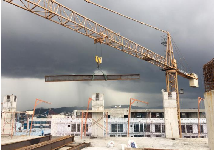
Ilustración 184.- Colocación de vigas metálicas con grúa torre Fuente: Jorge Romero
