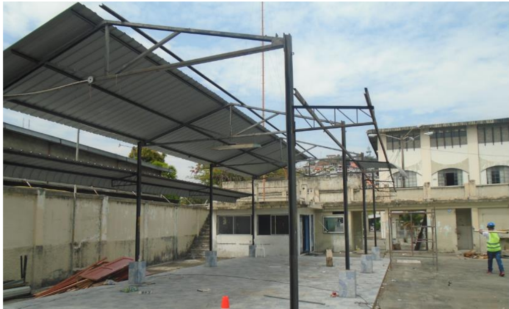
Ilustración 45.- Demolición de galpón
