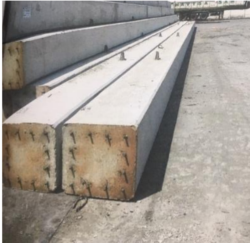
Ilustración 67.- Acopio de pilotes
