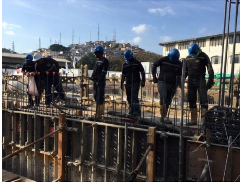
Ilustración 106.- Fundición de 2da etapa de muro perimetral Fuente: Autor
