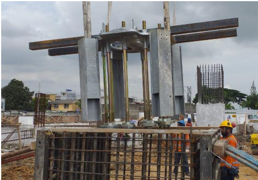
Ilustración 121.- Colocación de pernos de anclaje Fuente: Autor
