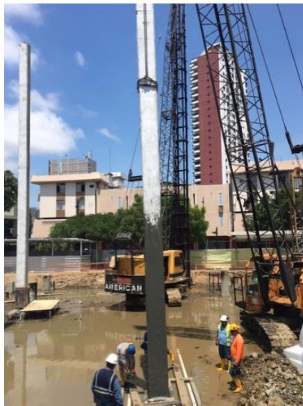
Ilustración 80.- Colocación de tramo inferior de pilote Fuente: Autor
