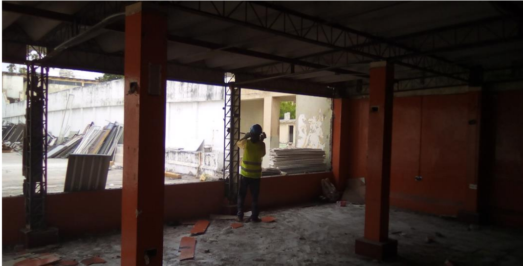
Ilustración 43.- Demolición de mampostería Fuente: Ing. Rafael Camacho
