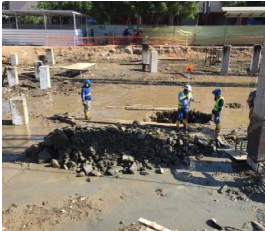
Ilustración 78.- Replanteo de coordenadas Fuente: Autor
