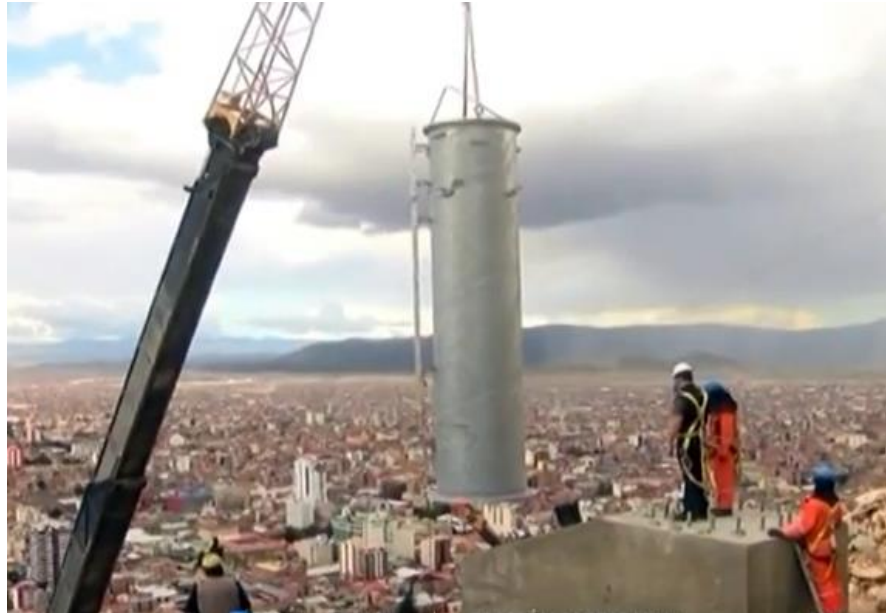
Ilustración 176.- Colocación de columnas metálicas en la cimentación Fuente: Internet
