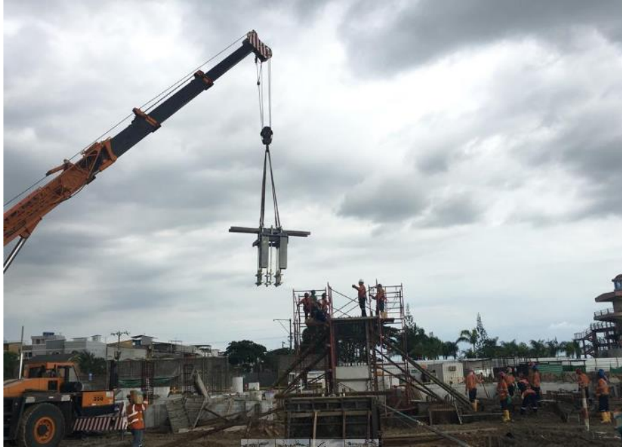
Ilustración 120.- Izaje de pernos de anclaje Fuente: Autor
