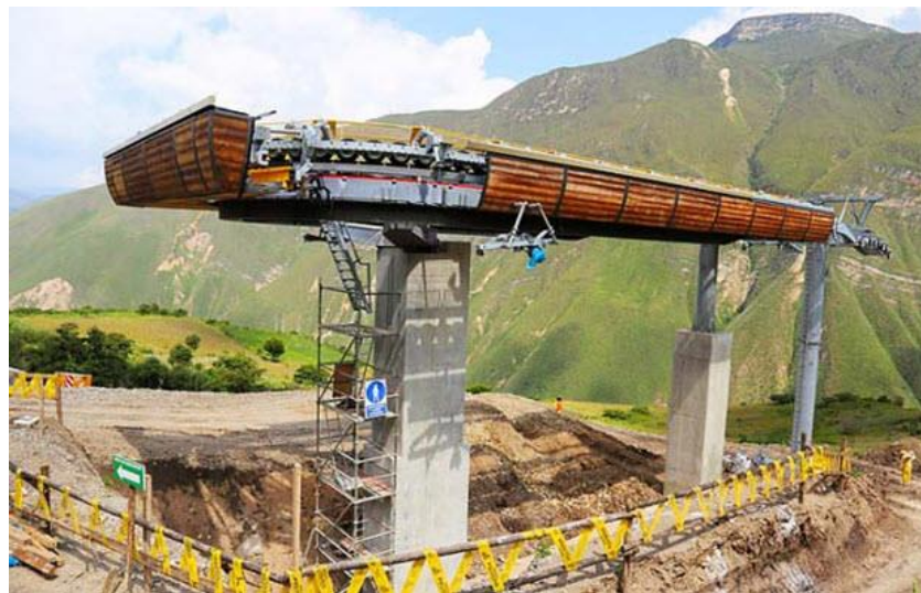
Ilustración 179.- Colocación de polea motriz Fuente: Internet
