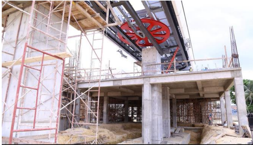
Ilustración 178.- Polea motriz en estaciones de transporte aero-suspendido Fuente: Internet
