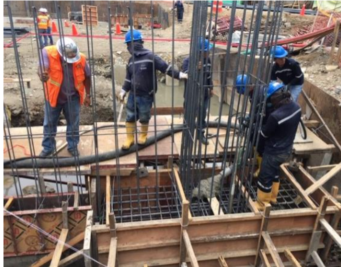
Ilustración 102.- Proceso de fundición Fuente: Autor
