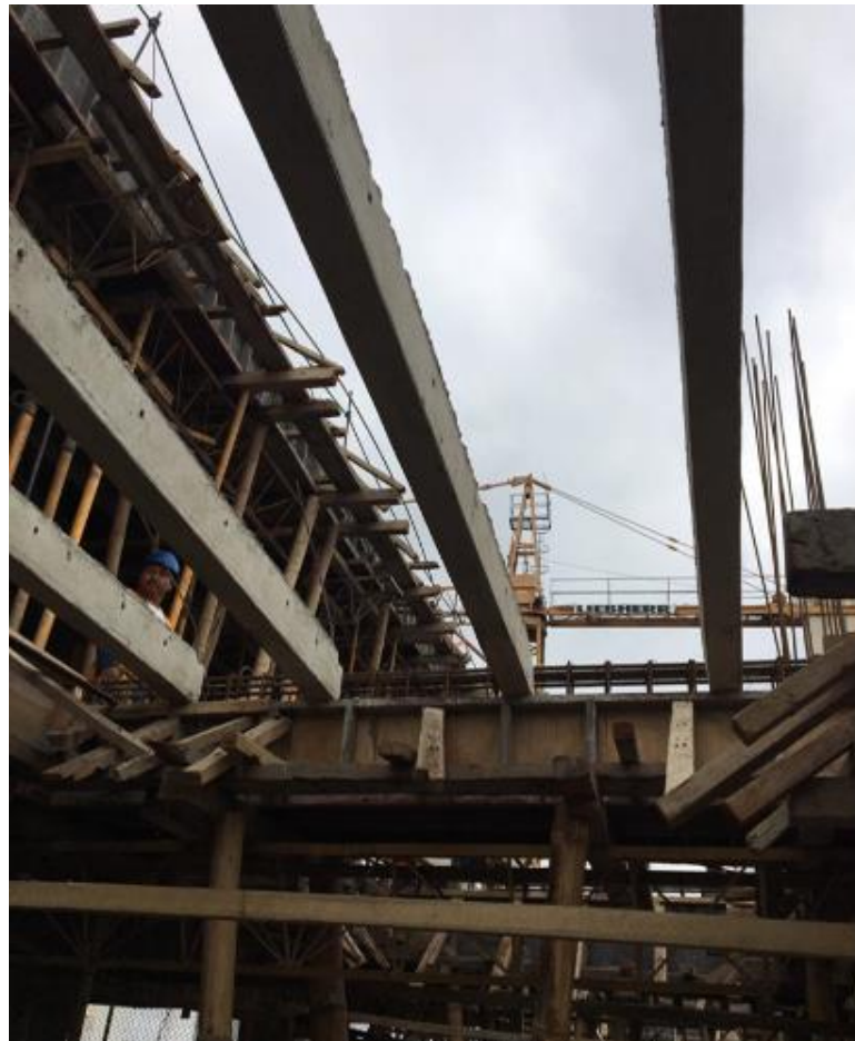
Ilustración 170.- Colocación de vigas presforzadas Fuente: Jorge Romero
