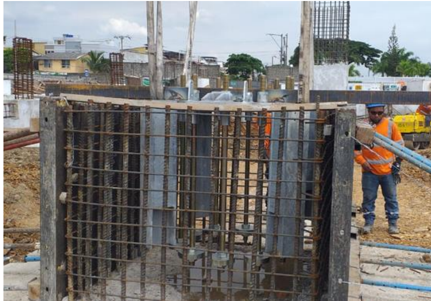
Ilustración 122.- Colocación en encofrado de pernos de anclaje Fuente: Autor
