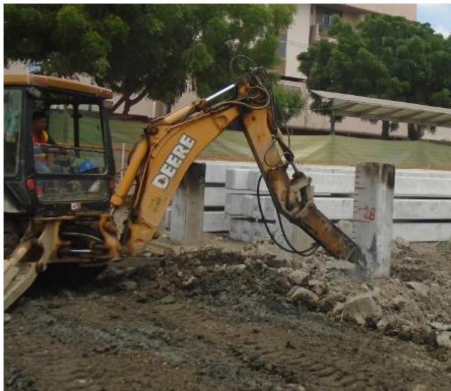
Ilustración 83.- Derrocado de pilote a nivel de terreno Fuente: Autor
