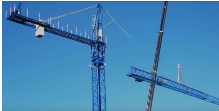
Ilustración 146.- Instalación de tramos finales de grúa torre Fuente: Internet
