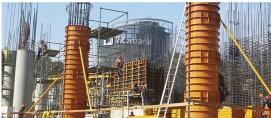
Ilustración 181.- Encofrado para columnas Fuente: Internet
