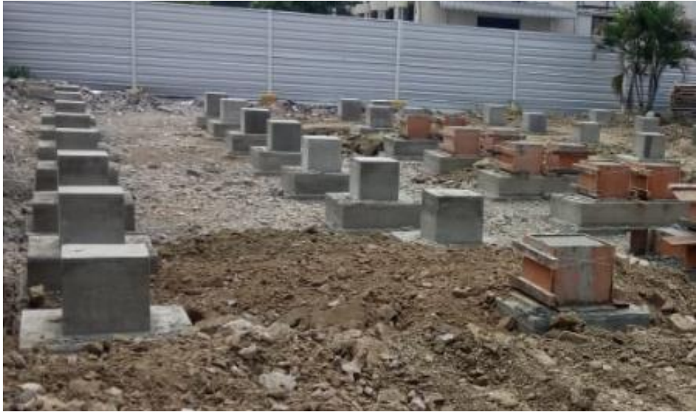
Ilustración 56.- Bases culminadas
