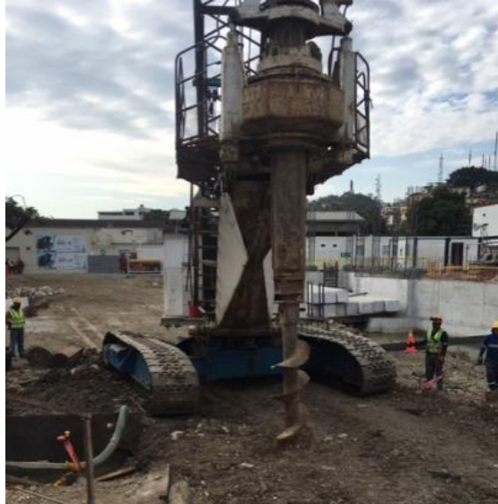
Ilustración 79.- Pre barrenado para hincado de pilotes Fuente: Autor
