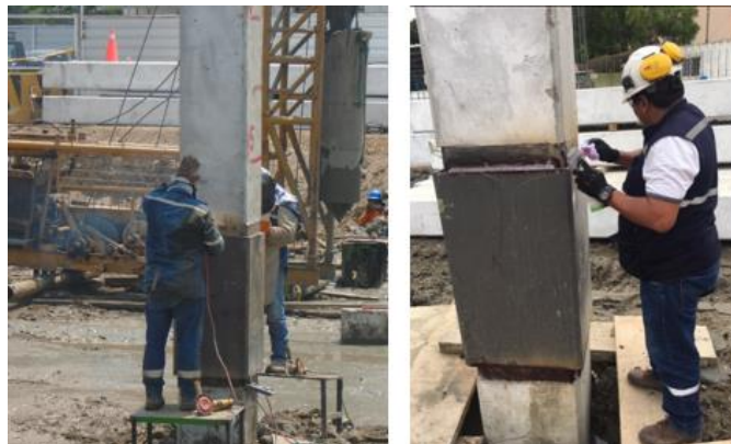
Ilustración 82.- Soldadura en acople de pilote Fuente: Autor
