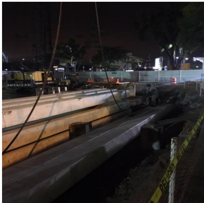
Ilustración 73.- Izaje de pilotes Fuente: Autor
