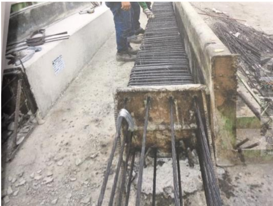
Ilustración 64.- Instalación de acero en pilotes Fuente: Ing. Aníbal García
