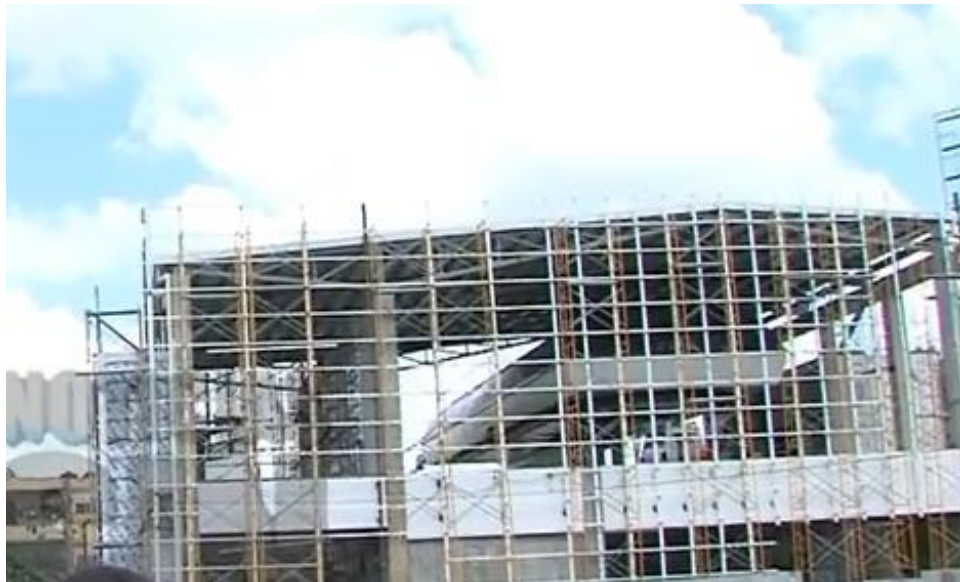
Ilustración 211.- Cubierta en estación de transporte aero-suspendido Fuente: Internet
