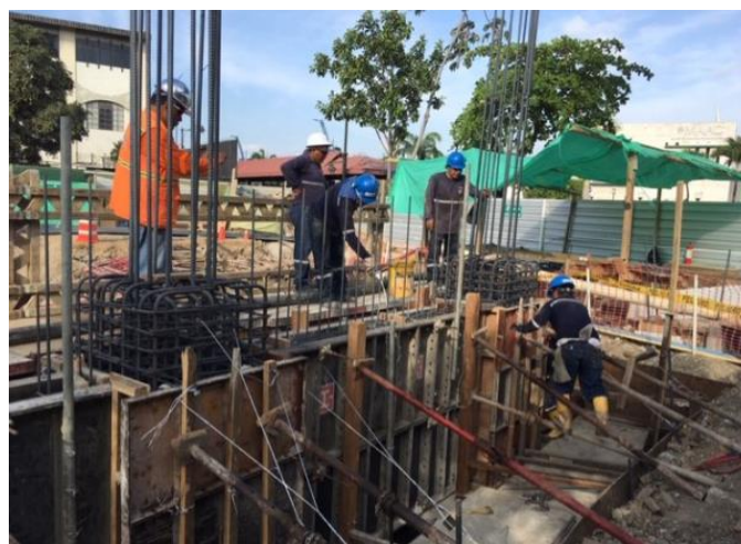
Ilustración 105.- Encofrado de muro perimetral para fundición de 2da etapa Fuente: Autor
