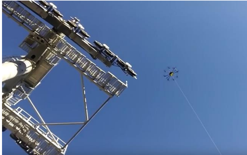
Ilustración 206.- Instalación de cable guía mediante dron
