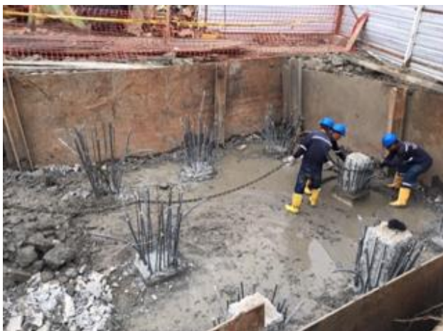
Ilustración 93.- Descabezado total de pilotes Fuente: Autor
