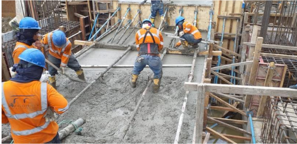
Ilustración 131.- Fundición de viga riostra de cimentación Fuente: Autor
