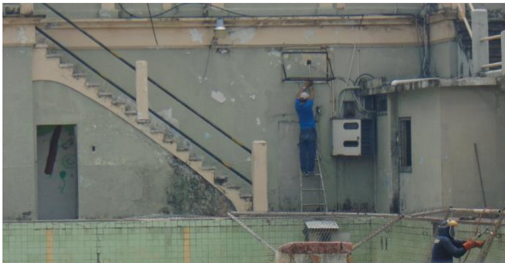
Ilustración 42.- Retiro de elementos no estructurales Fuente: Ing. Rafael Camacho
