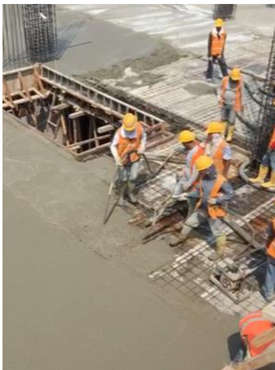
Ilustración 172.- Fundición de losa con vigas presforzadas Fuente: Jorge Romero
