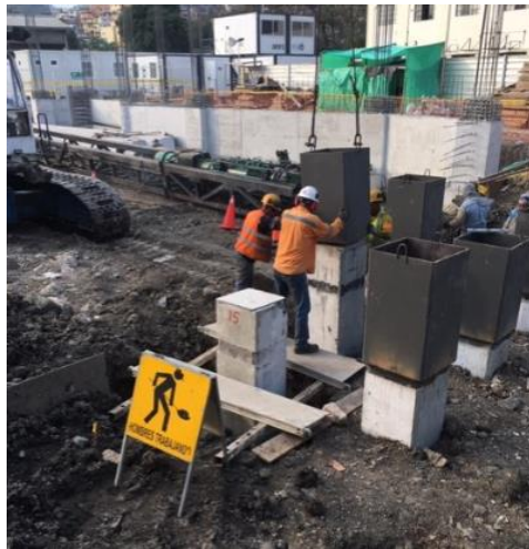
Ilustración 81.- Colocación de capuchón metálico Fuente: Autor
