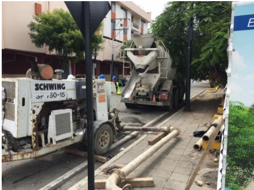
Ilustración 117.- Fundición de pilona P.16-17 Fuente: Autor
