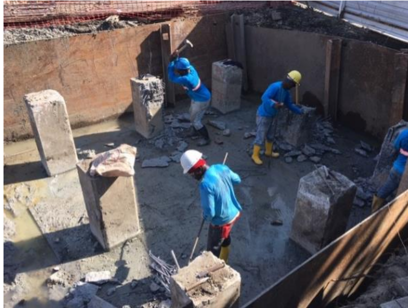
Ilustración 92.- Descabezado de pilotes Fuente: Autor
