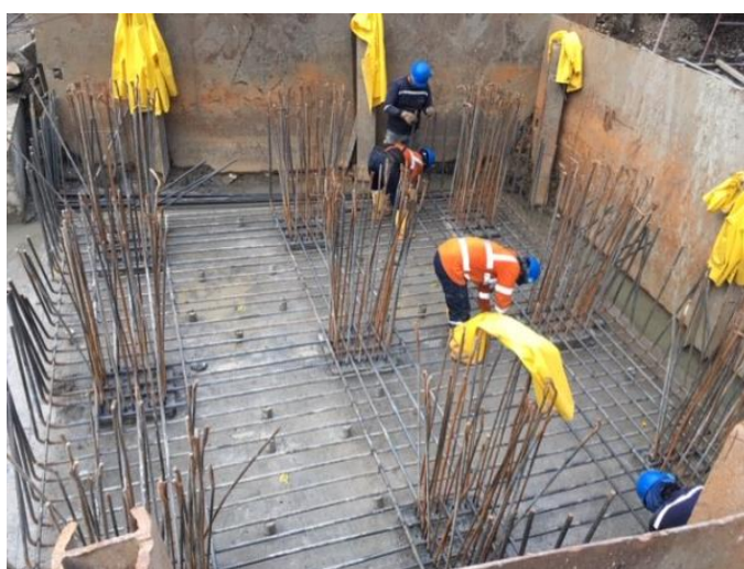
Ilustración 113.- Armado de parte inferior de piona P.16-17 Fuente: Autor
