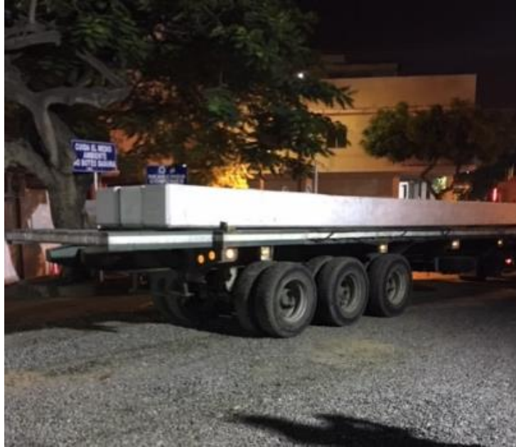
Ilustración 72.- Llegada de pilotes a Estación 04 Fuente: Autor
