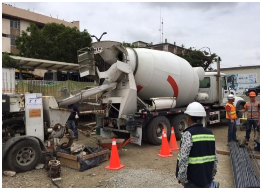
Ilustración 101.- Vaciado de hormigón en bomba Fuente: Autor
