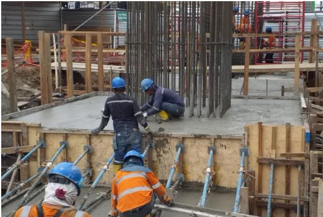
Ilustración 132.- Fundición de cabezal de G4 B Fuente: Autor
