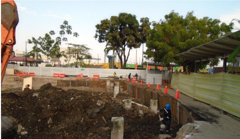
Ilustración 62.- Entibado metálico
