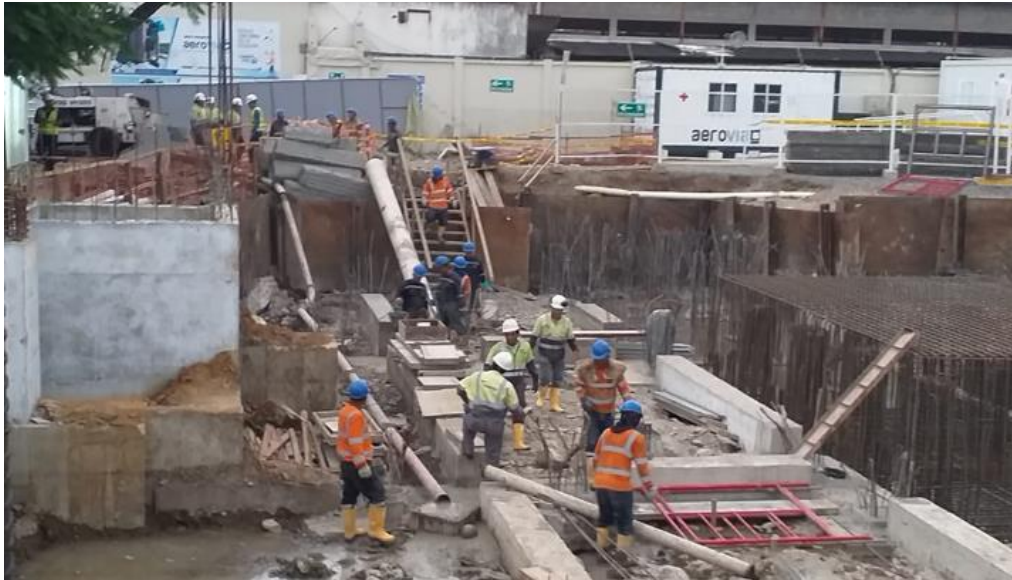
Ilustración 129.- Colocación de tuberías para la fundición Fuente: Autor
