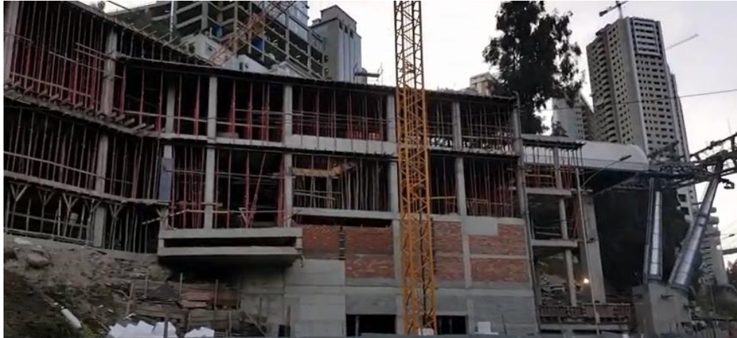
Ilustración 192.- Apuntalamiento de losas en estaciones de aero-suspendido
