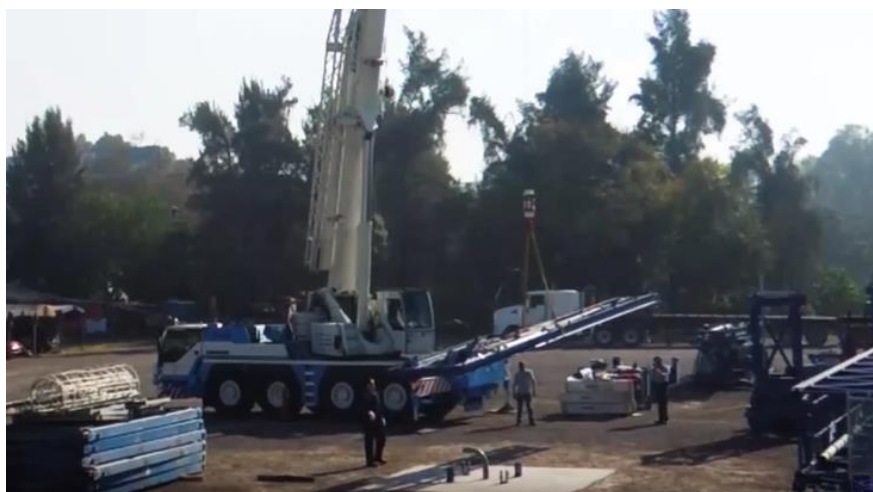
Ilustración 144.- Instalación de tramo inicial de grúa torre Fuente: Internet
