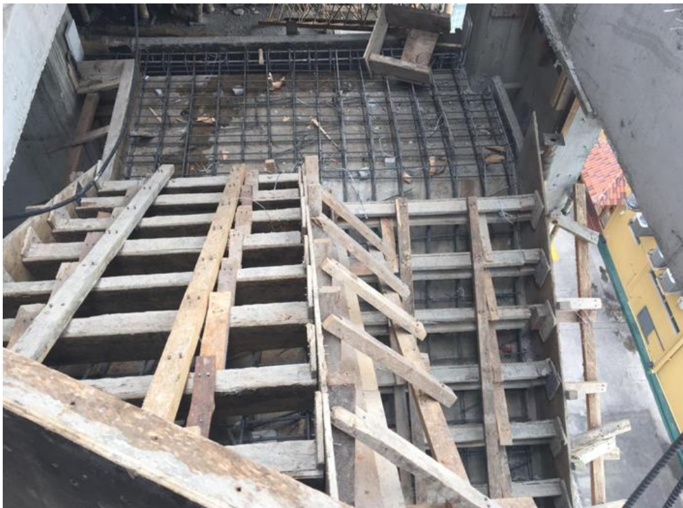
Ilustración 193.- Fundición de escaleras
