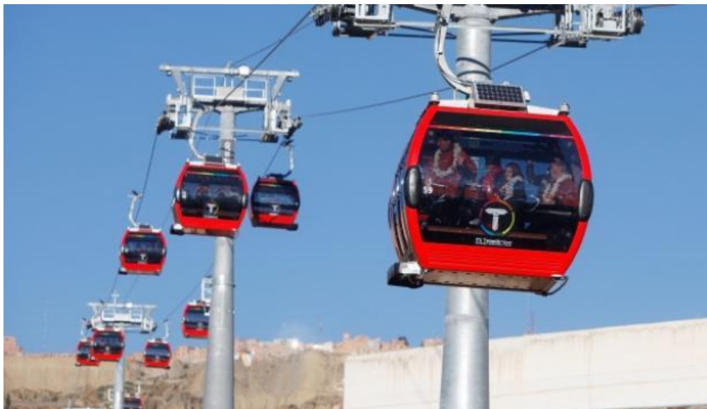
Ilustración 20.- Pilonas tubulares Fuente: Internet
