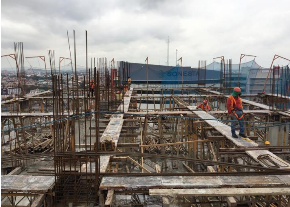
Ilustración 168.- Encofrado de vigas para losa presforzada
