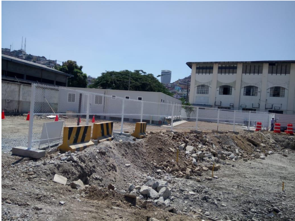
Ilustración 61.- Cerramiento en obra Fuente: Ing. Rafael Camacho
