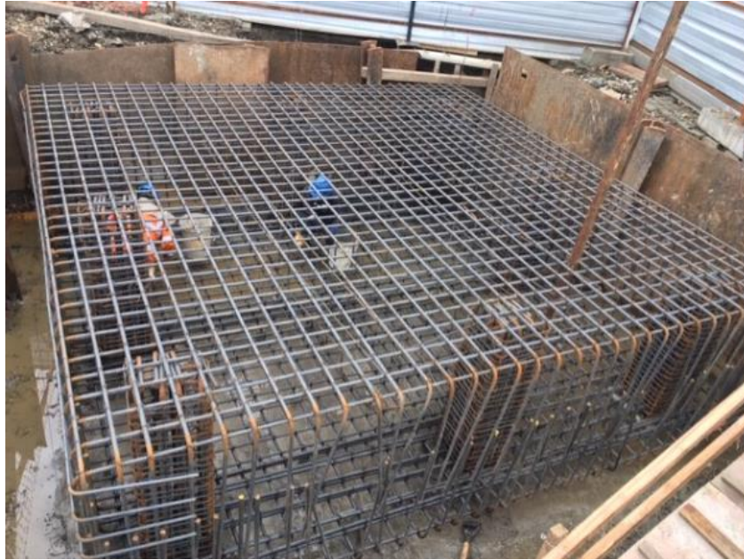
Ilustración 114.- Armado de parte superior de Pilona P.16-17 Fuente: Autor
