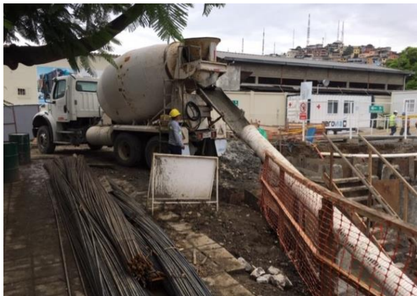
Ilustración 140.- Mixers para fundiciones de elementos de cimentación Fuente: Autor
