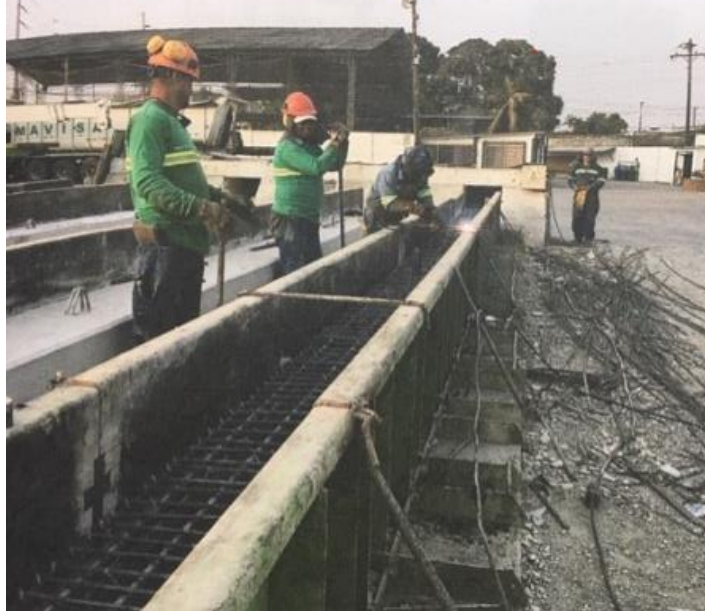
Ilustración 65.- Encofrado metálico para pilotes
