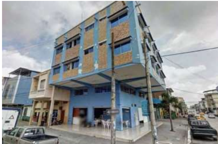
Ilustración 13 Edificio en Ayacucho y García Moreno antes del sismo del 2016 (FUENTE: Google maps)
