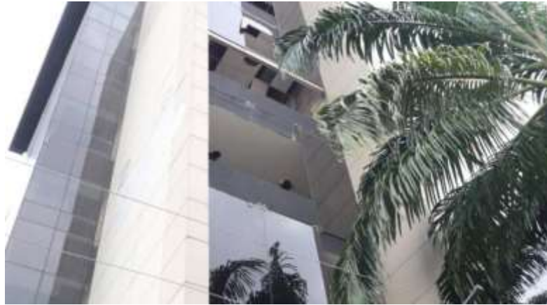
Ilustración 7 Edificio Vihcar con daños internos y externos en su estructura.
