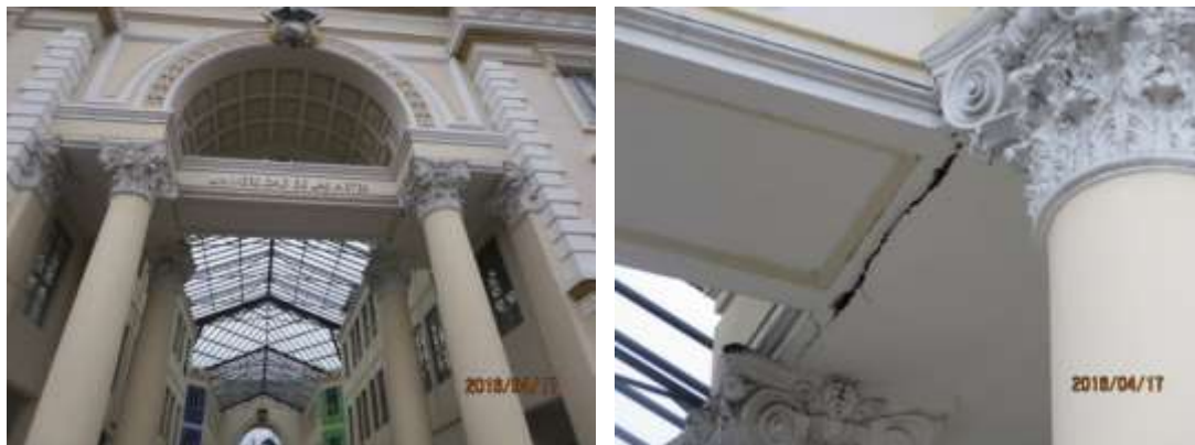
Ilustración 4 Daños en el Palacio de la Gobernación del Guayas después del sismo del 2016
