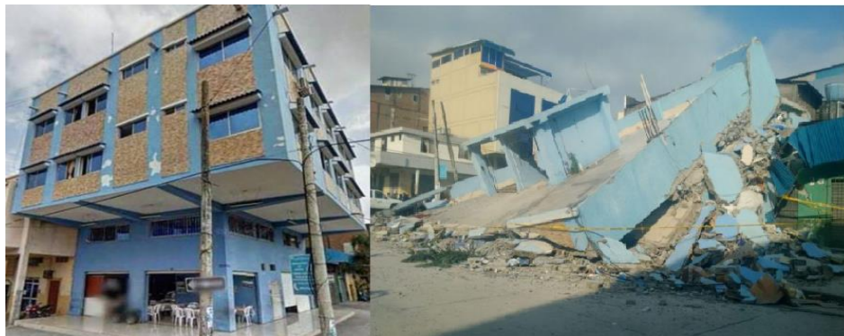
Ilustración 71. Daños en condominio ubicado en Ayacucho y García Moreno. Fuente: (Radio Morena, 2016)
