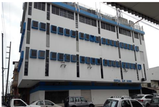
Ilustración 14. Ex-edificio de EMETEL año 2016.
