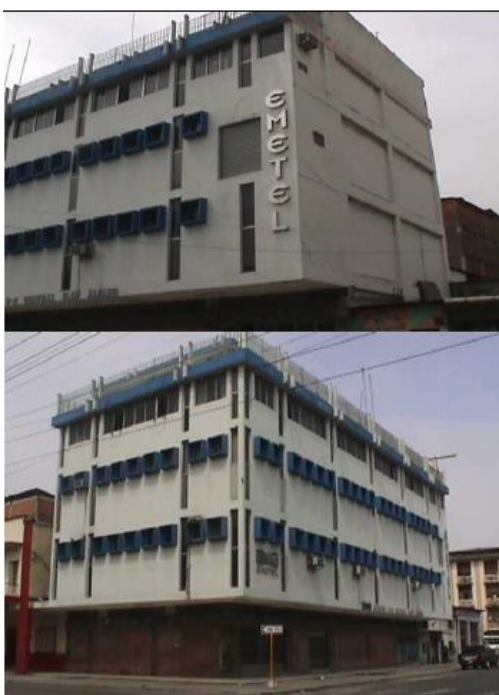
Ilustración 13. Edificio EMETEL año 1992. Fuente: (PROYECTO RADIUS, 1999)
