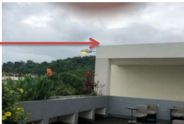
Figura 37. Ubicación seleccionada para la instalación de la solución IoT
