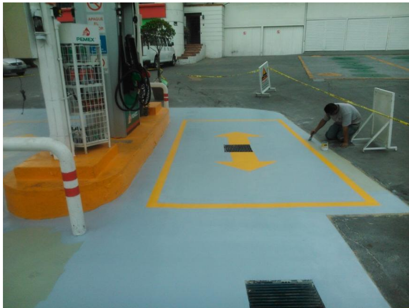
Figura 1 Nueva aplicación de pintura
