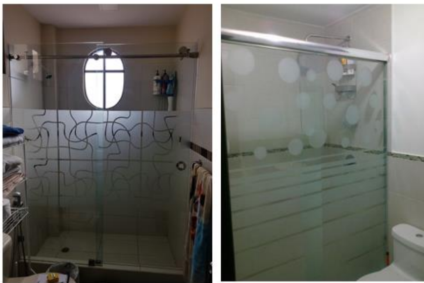
Figura 9. Vidrio templado en baños
