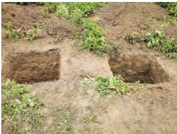
Imagen 1: Abscisa 0+000. Excavación de pozos.
