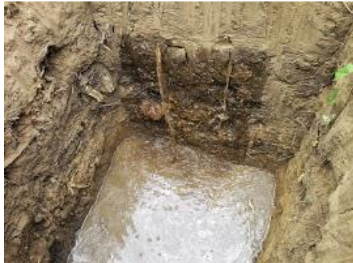
Imagen 8: Abscisa 1+000. Aparición del gasto variable en el estrato permeable.
