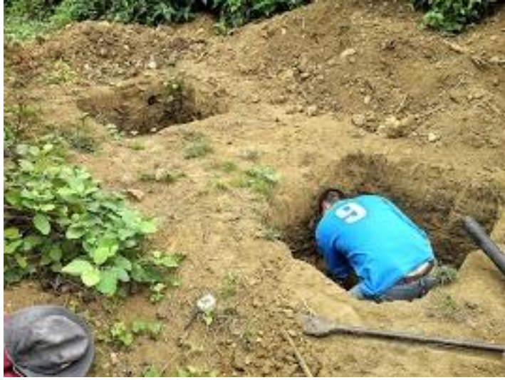
Imagen 5: Abcisa 1+000. Excavación de los pozos.
