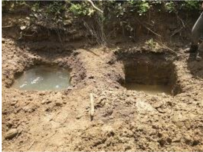
Imagen 13: Abscisa 9+600. Excavación de los pozos.
