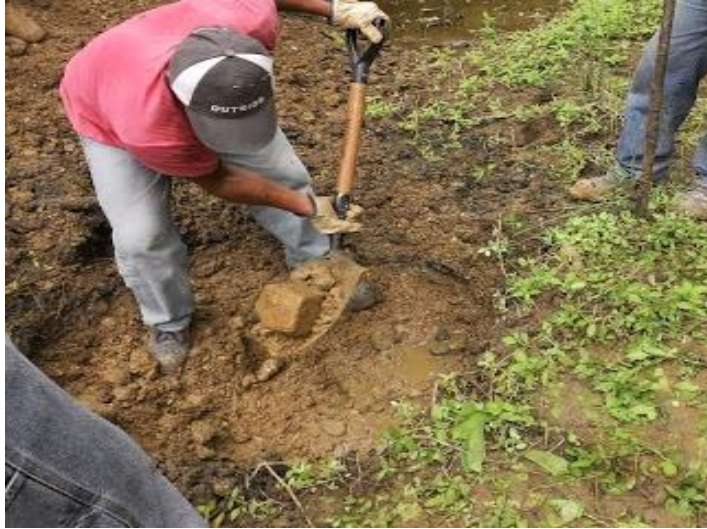
Imagen 9: Abscisa 4+100. Excavación de los pozos.
