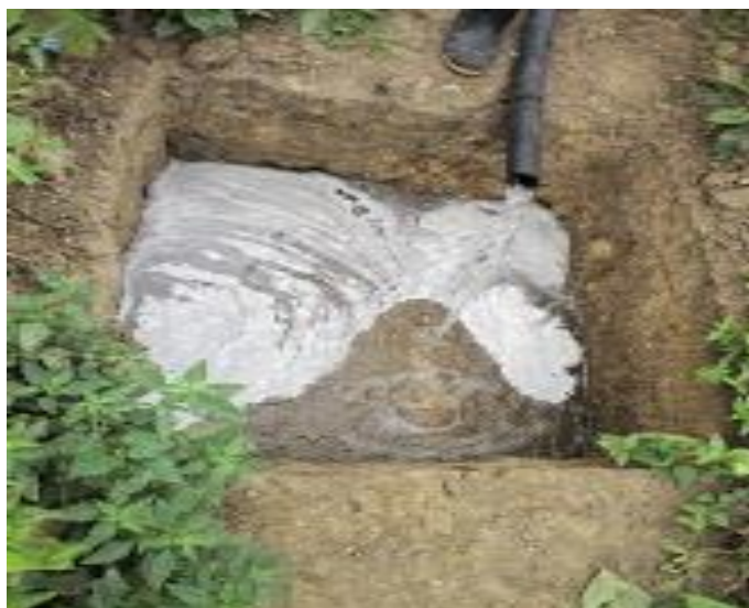
Imagen 2: Abscisa 0+000. Ejecución de la prueba en campo con gasto variable.
