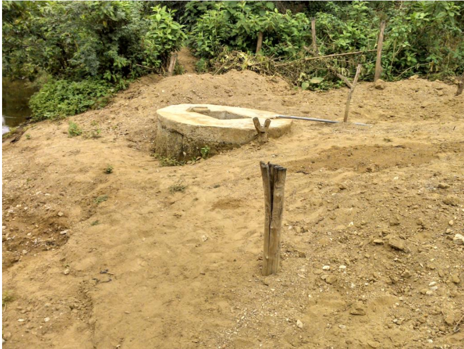
Figura 3.11. Construcción de pozo, abscisa 10+500.00 en comuna Iceras.
