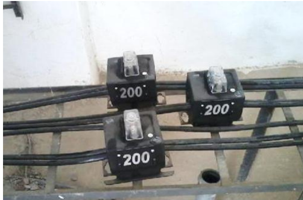
Figura: 2.23: Transformadores de corrientes
