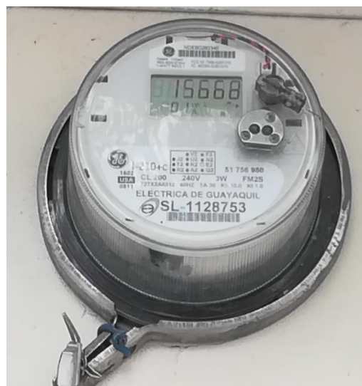
Figura 3.4: Medidor Inteligente.
