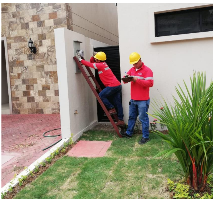
Figura 3.8: Instalación de medidor inteligente
