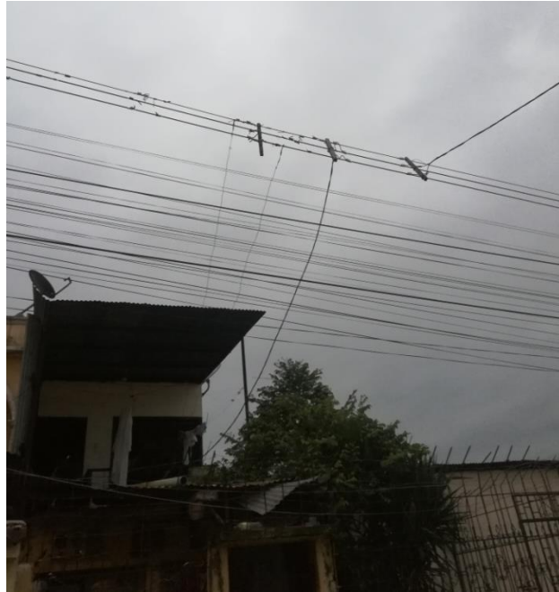
Figura 4.3: Conexión directa del usuario.
