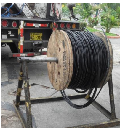
Figura 2.8: cable tipo preensamblado
