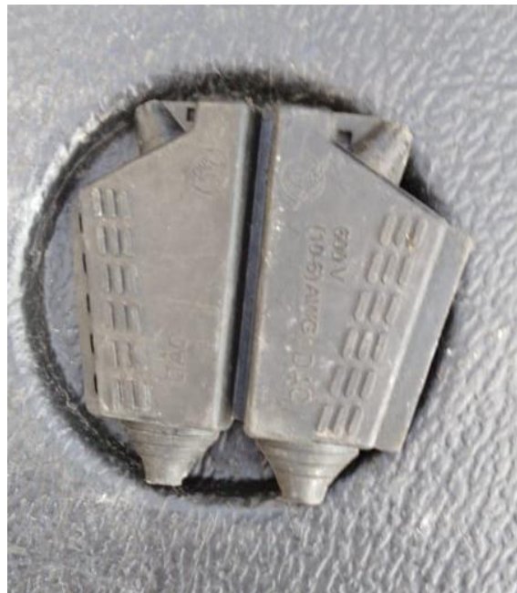
Figura 2.16: Porta neutro para acometida concéntrica de sistema preensamblado.
