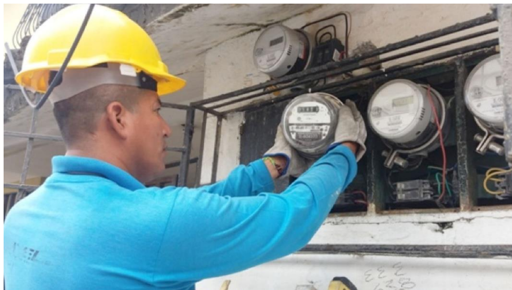
Figura 3.7: Cambio de medidor inteligente.
