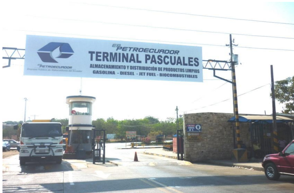
Figura 2.1 Terminal de Productos Limpios Pascuales
