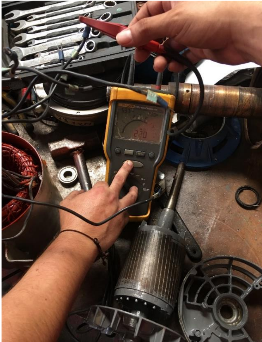
Figura 31: Prueba con el Megohmmeter a los terminales. Tomada de: Autor
