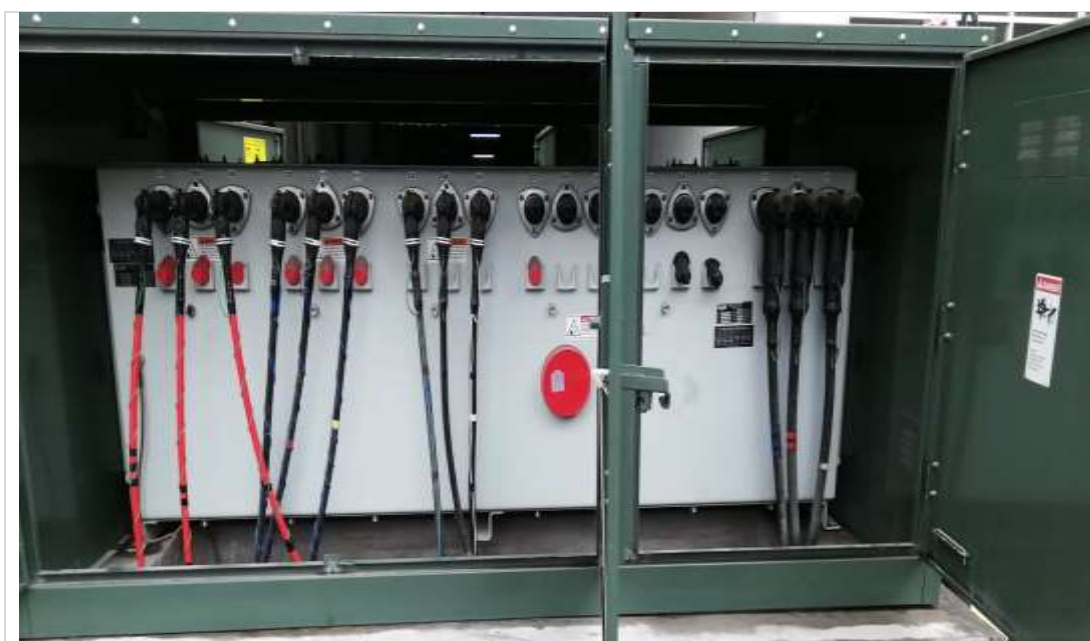
Figura 4.4: Conexión de entrada y salida de alimentación. (vista frontal)
