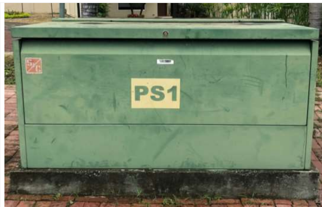
Figura 4.1: Interruptor de distribución vista tipo pedestal.
