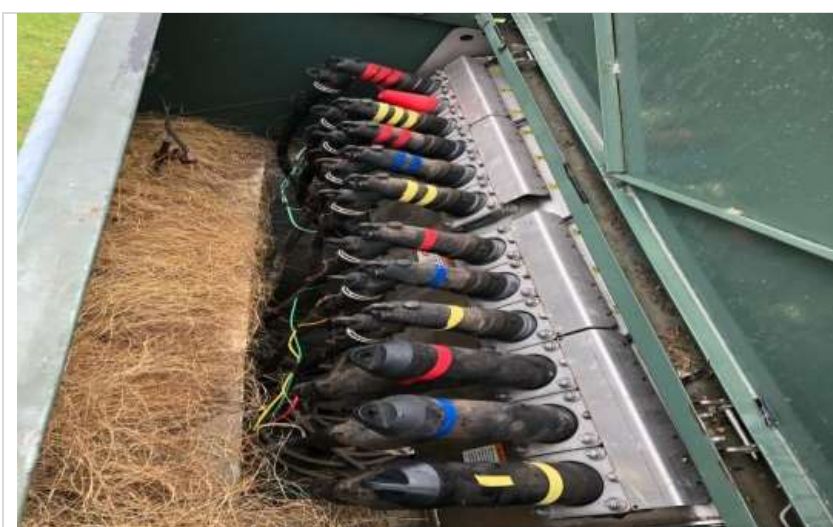
Figura 4.10: Rotulación con cintas de colores en cada fase.
