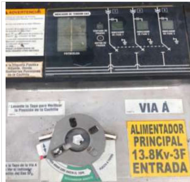
Figura 4.5: Alimentación principal (vista superior)
