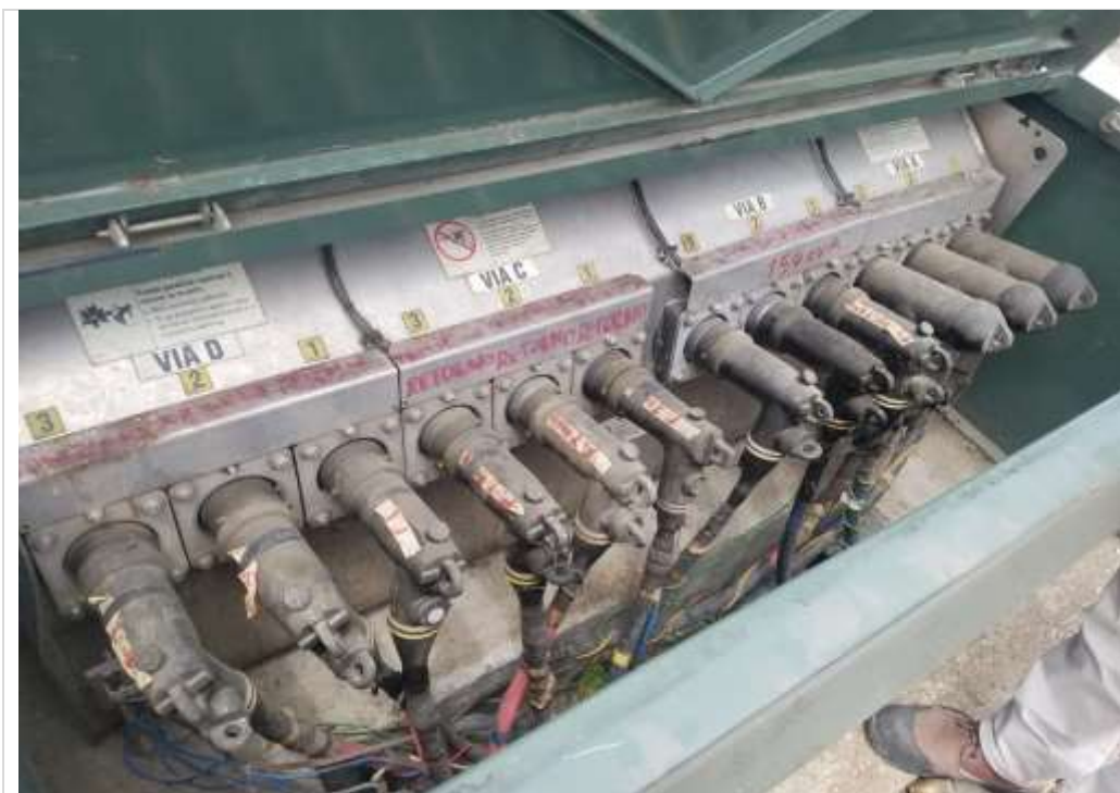
Figura 2.17 Conector tipo codo 15KV, 25KV y 35KV para 200 Amperes
