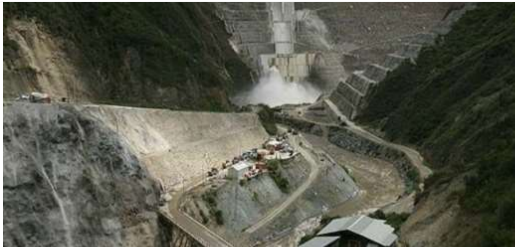
Figura 2.1: Generación de energía eléctrica en Mazar
