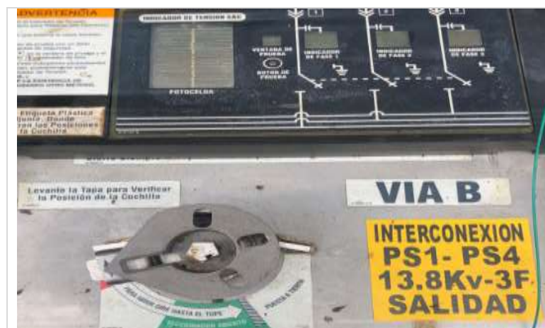
Figura 4.6: Interconexión actual del switch vista (vista superior)
