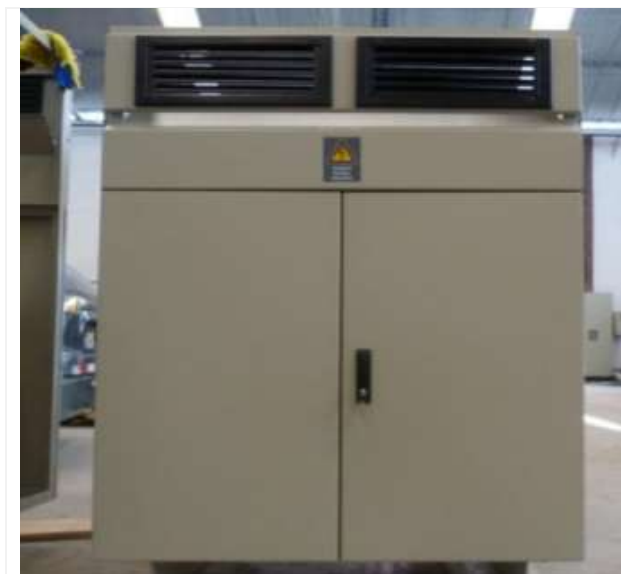
Figura 2.20 Transformador reductor/elevador de voltaje ST-2000
