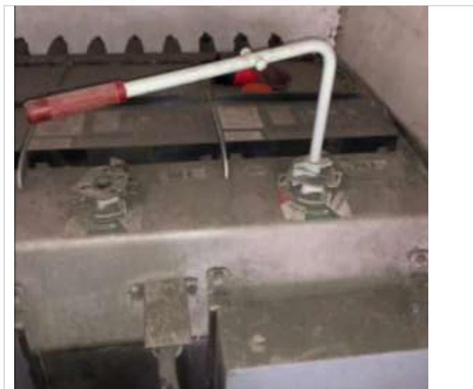
Figura 4.8: Manija para maniobra del switch vista
