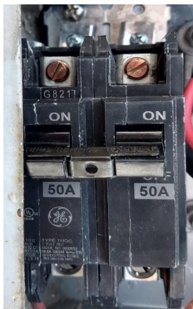
Figura 4. 9. Instalación de breaker principal.
