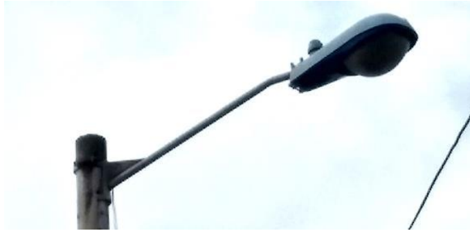
Figura 2. 27. Lámpara tipo cobra
