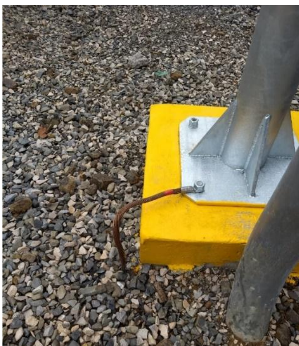
Figura 2. 24. Sistema puesta a tierra
