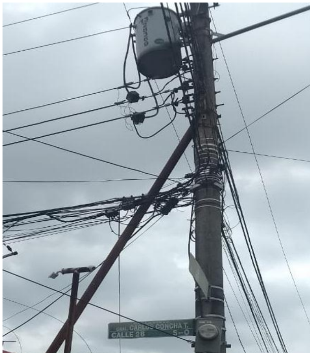
Figura 4. 6. Instalación de controlador de circuito
