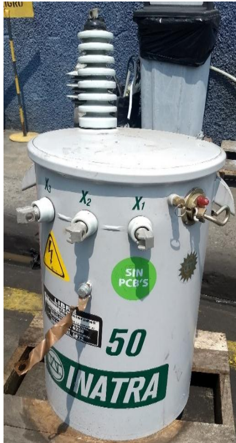
Figura 2. 29. Transformador monofásico tipo auto protegido
