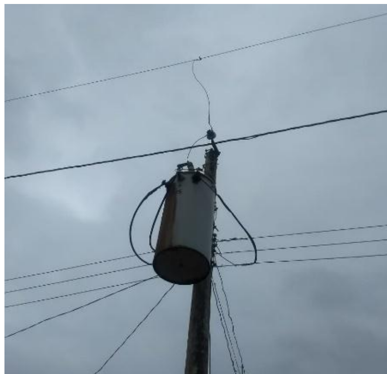
Figura 2. 6. Red de distribución monofásica
