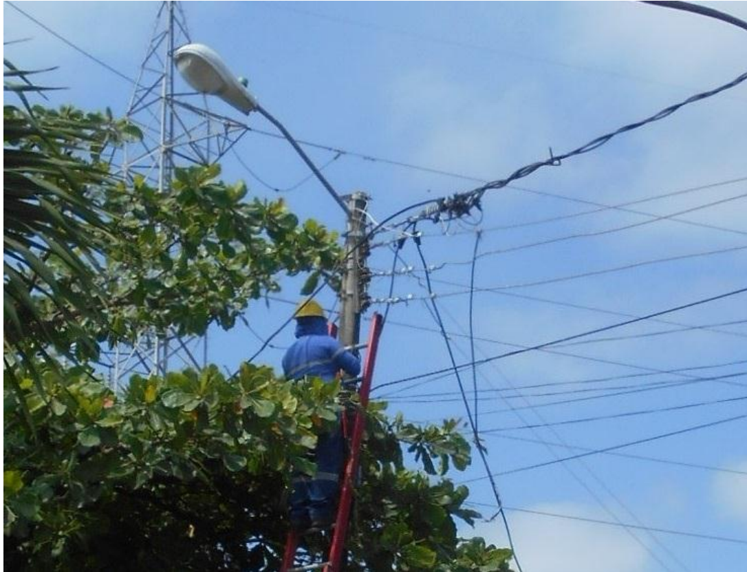
Figura 4. 4. Instalación de luminaria
