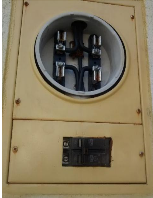
Figura 4. 8. Modulo para medidor 120V/240V
