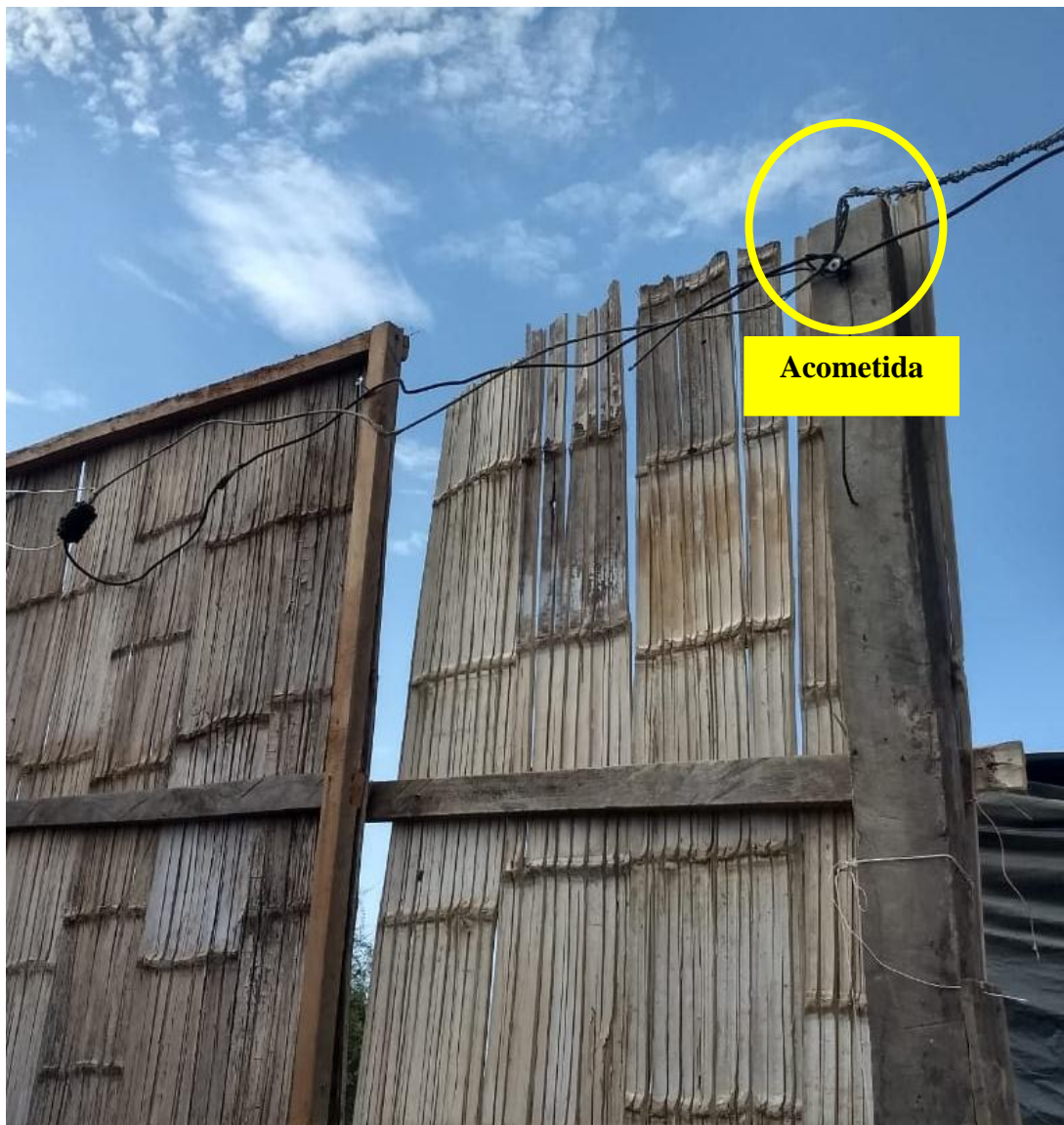
Figura 3. 7. Acometida de la manzana #14
