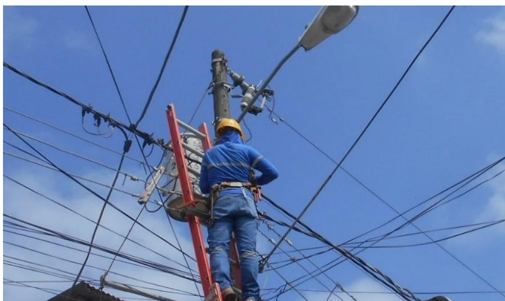
Figura 4. 3. Instalación del transformador
