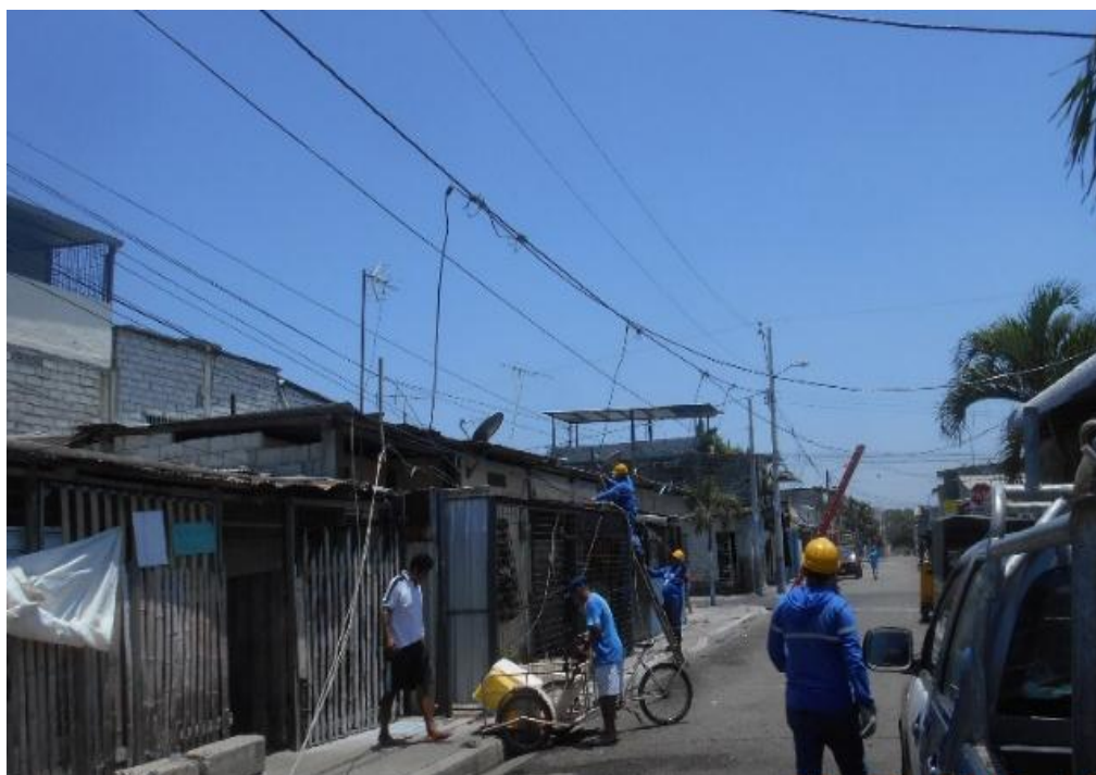
Figura 4. 1. Personal instalando la red preensamblada, acometida, medidores.
