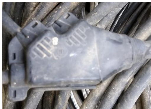
Figura 2. 49. Derivador plástico para conductor concéntrico.
