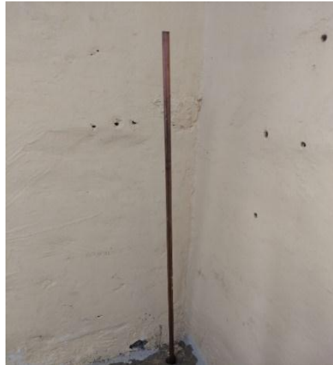
Figura 4. 10. Instalación de varilla puesta a tierra
