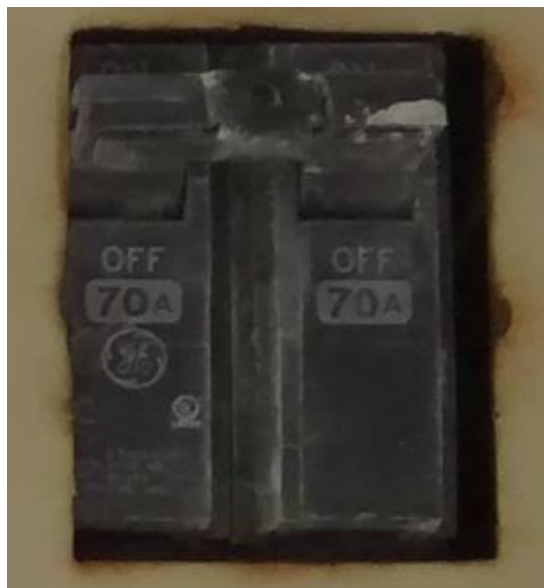
Figura 2. 38. Disyuntor de protección
