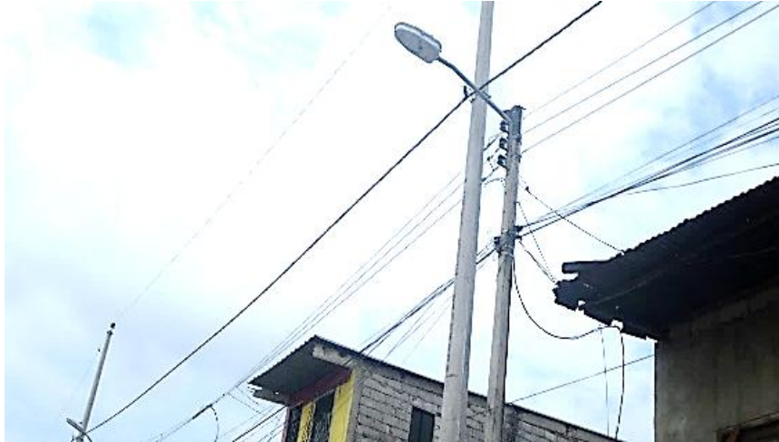
Figura 4. 5. Instalación de la red preensamblada
