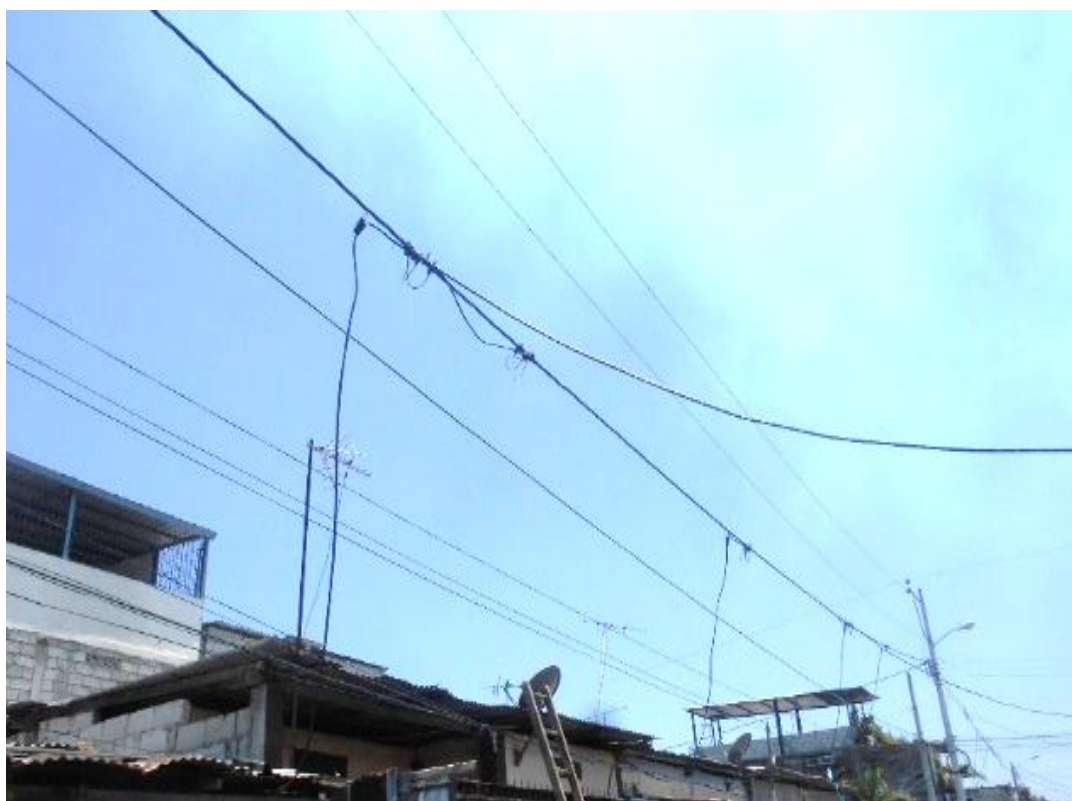
Figura 4. 7. Instalación de acometida triplex antihurto
