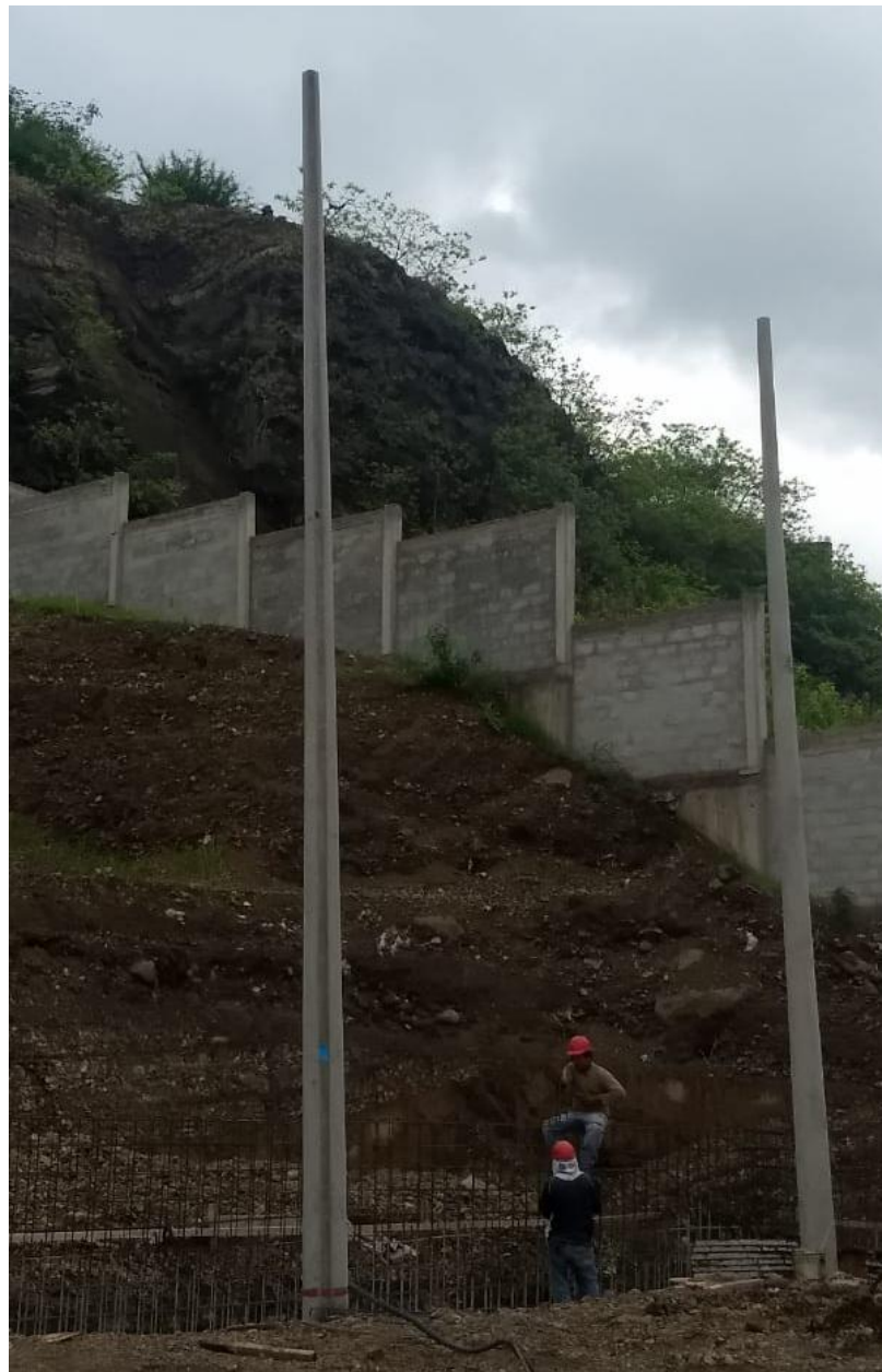
Figura 4. 2. Instalación de postes
