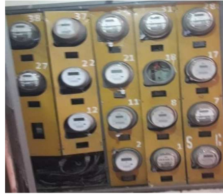
Figura 3.14 Tablero lado este Fuente: El autor
