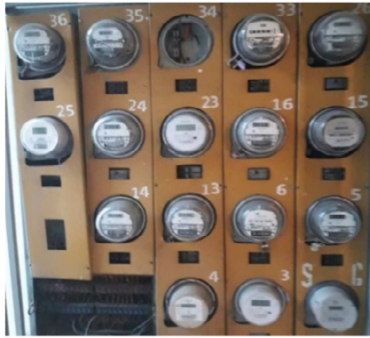
Figura 3.13 Tablero lado oeste Fuente: El autor
