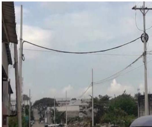
Figura 2.13 Acometida aéreas Fuente: El autor
