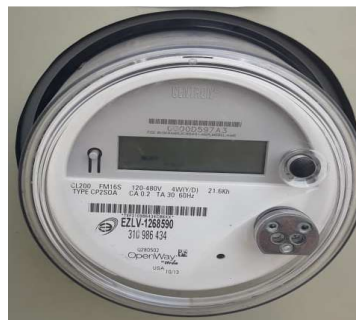
Figura 2.19 Medidor trifásico Fuente: El autor
