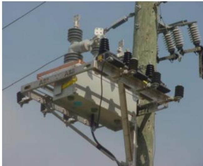
*Ilustración 11 Reconector en poste ABB, OVR
