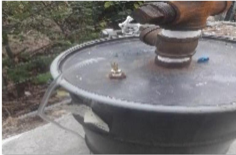
*Figura N° 29 Instalación de manómetro en el filtro*
