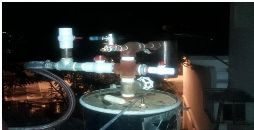
*Figura N° 34.1 Montaje de elementos de control de gas*
