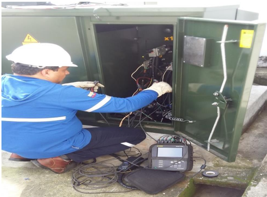
Figura 3. 11: Instalación del equipo portátil Power Pad modelo 8335
