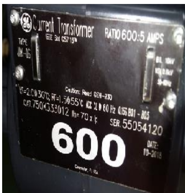
Figura 2. 9: Placa de transformador de rango extendido
