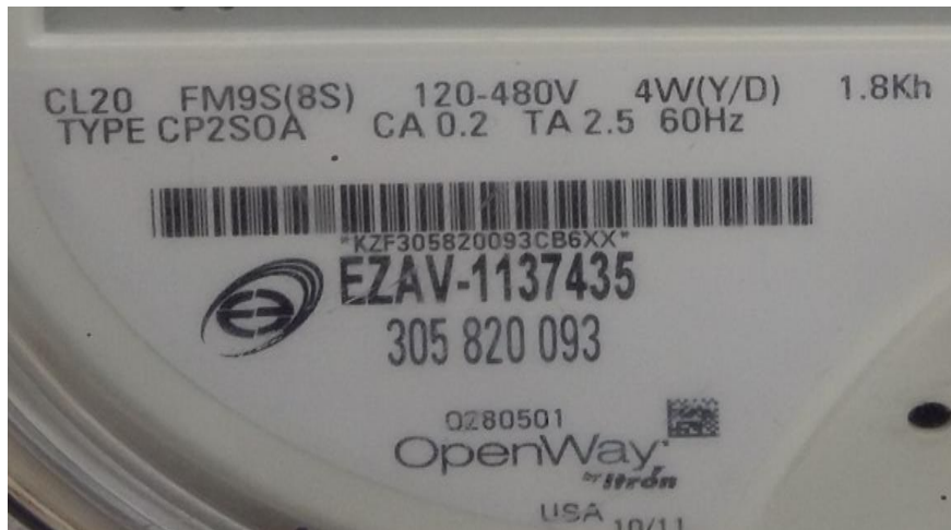
Figura 2. 14: Placa característica de un medidor electrónico Fuente: (Mazzini, 2006)
