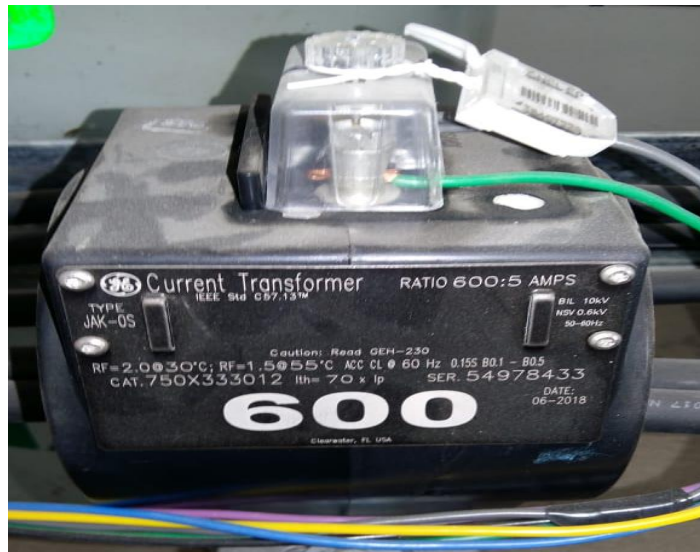
Figura 2. 8: Transformador de rango extendido
