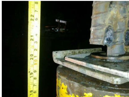
Figura # 30 Cordón de soldadura a la varilla de 25mm
