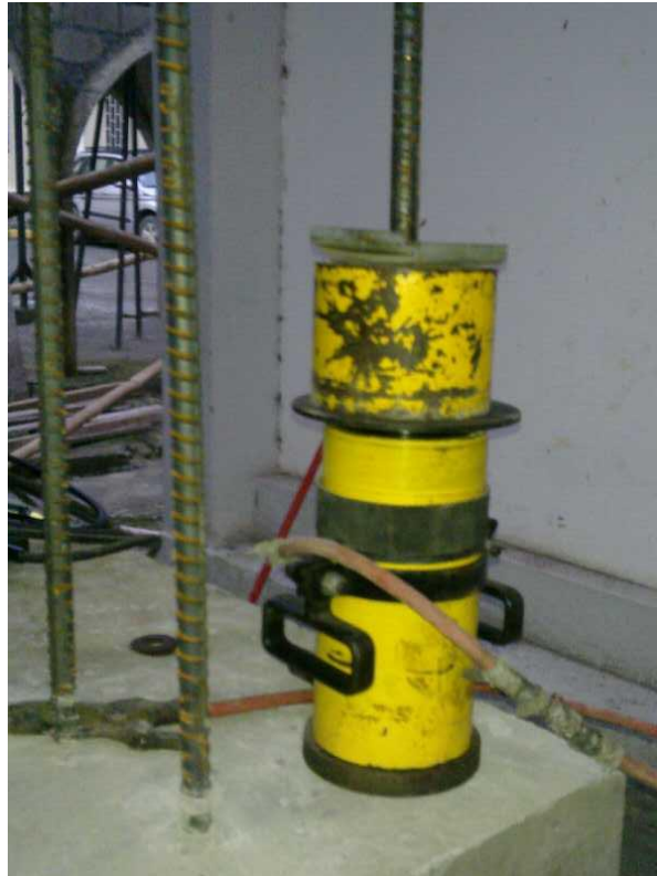
Figura # 27 El gato introducido en la varilla de 25mm
