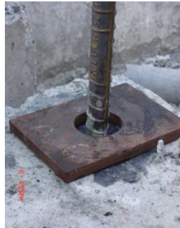
Figura # 25 Placa haciendo contacto con el dado de hormigón
