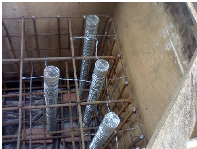
Figura # 07 colocación de tubos postensados
