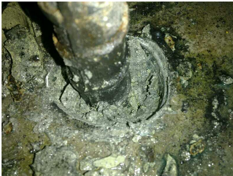
Figura # 37 Falla del azufre por adherencia a la varilla de 25mm.
