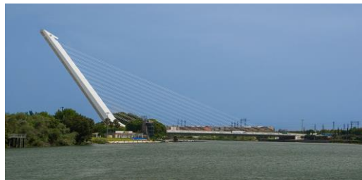
Figura 3-11 Puente del Alamillo (Sevilla, España).
