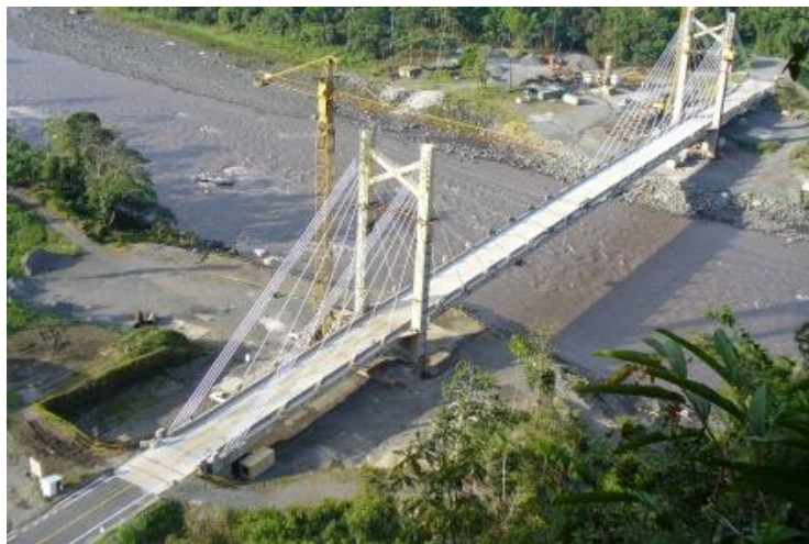
Figura 3-10 Puente de Obenque Rio Pastaza.
