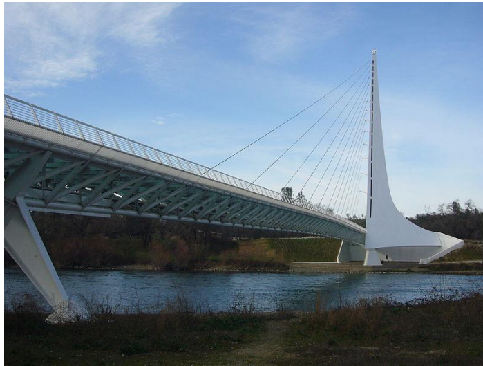
Figura 3-12 Puente del Reloj de Sol (Redding, E.E.U.U.).
