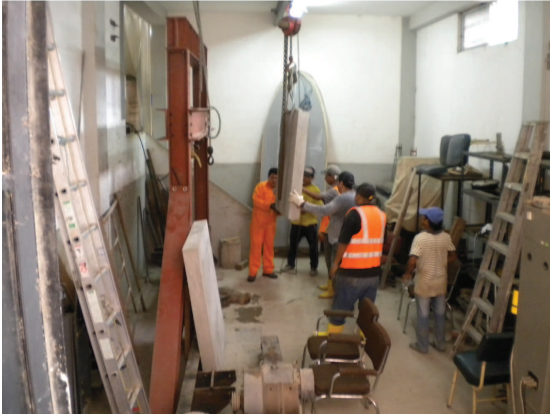
Foto 16. Transporte y ubicación de las paredes con ayuda de personal.
