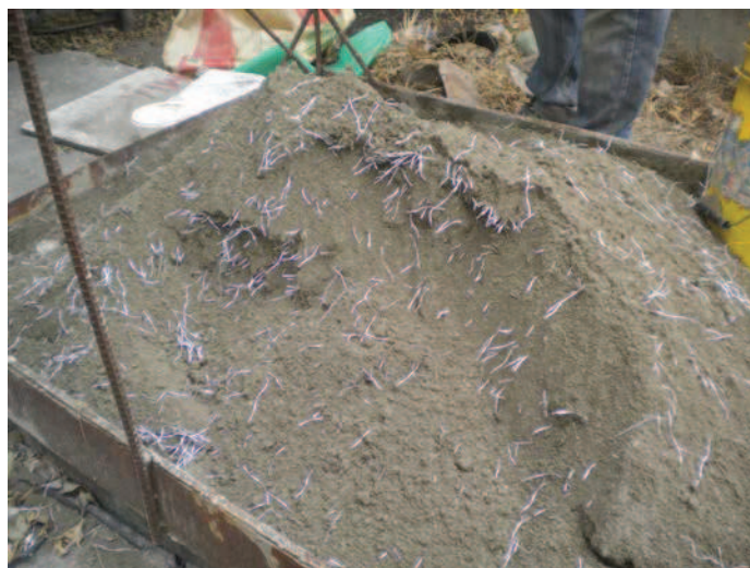
Foto 4. Mezcla de 1 saco de cemento, arena y la fibra de polipropileno.
